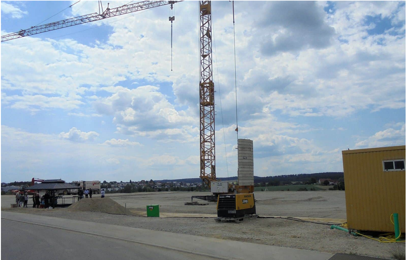
Auf diesem Grundstück entsteht das neue DISTO-Werk. Foto: him
