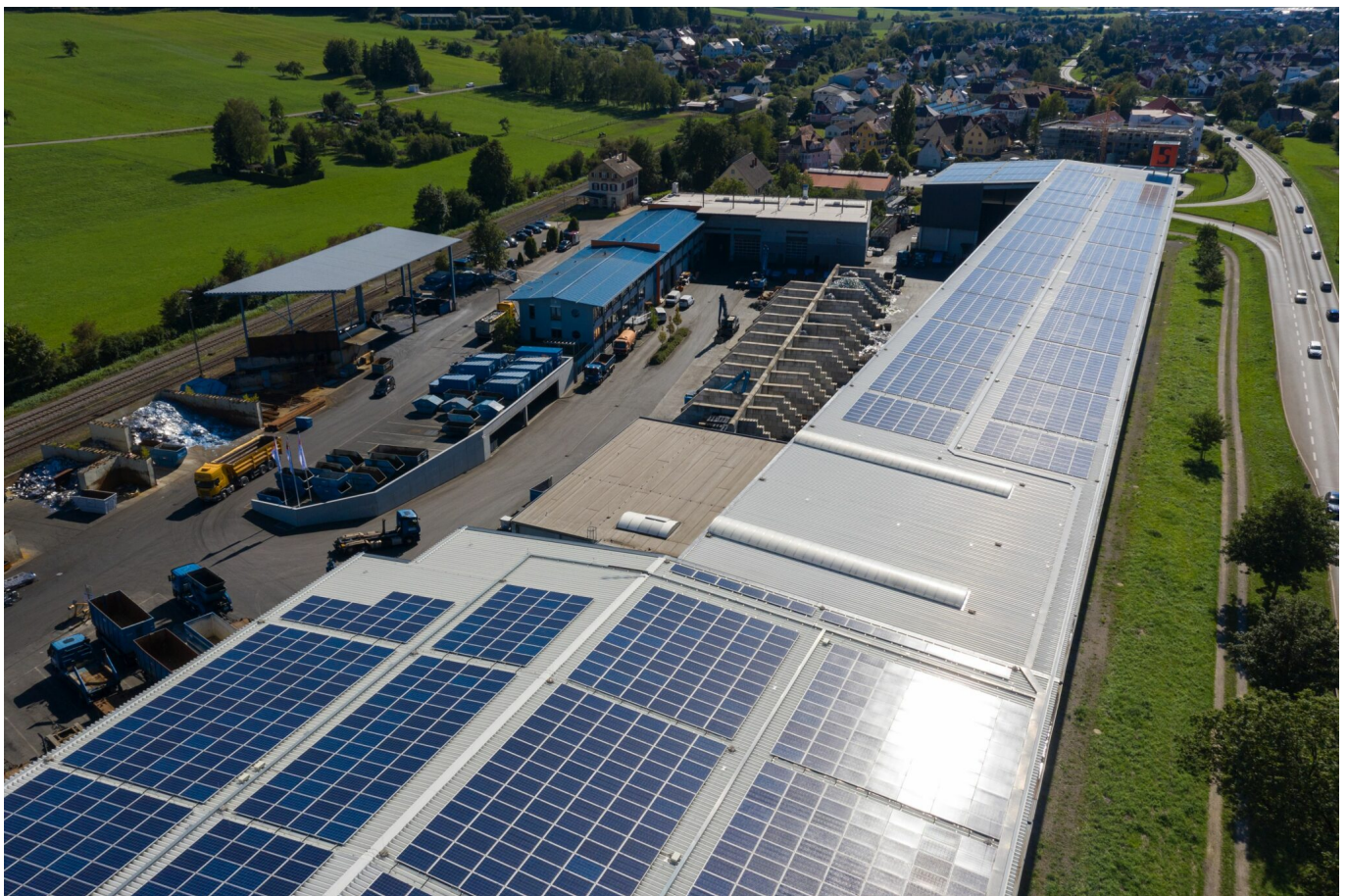
Der Solarstromausbau im Südwesten macht große Fortschritte – Fotovoltaikanlage auf einem Gewerbedach in Deißlingen. Foto: Plattform EE BW / Kuhnle & Knödler
