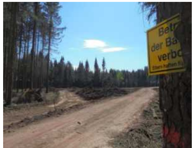
Große Flächen wurden frei gemacht, um die Anlagen aufbauen zu können. Ein Gutteil wird später wieder aufgeforstet.
