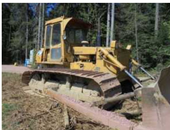
Schweres Gerät vor Ort
