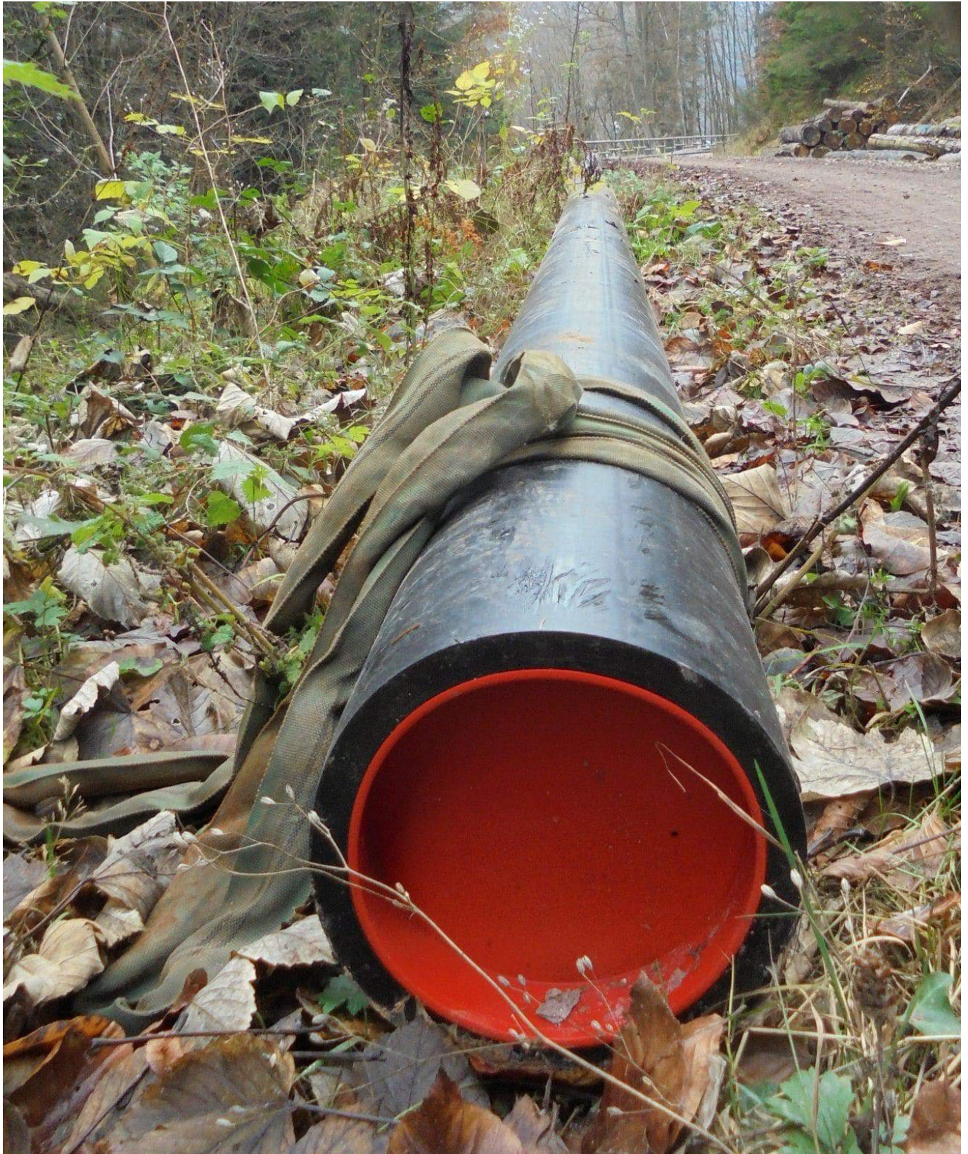
Das lange Leerkrohr: bereit zum Einziehen werden.
