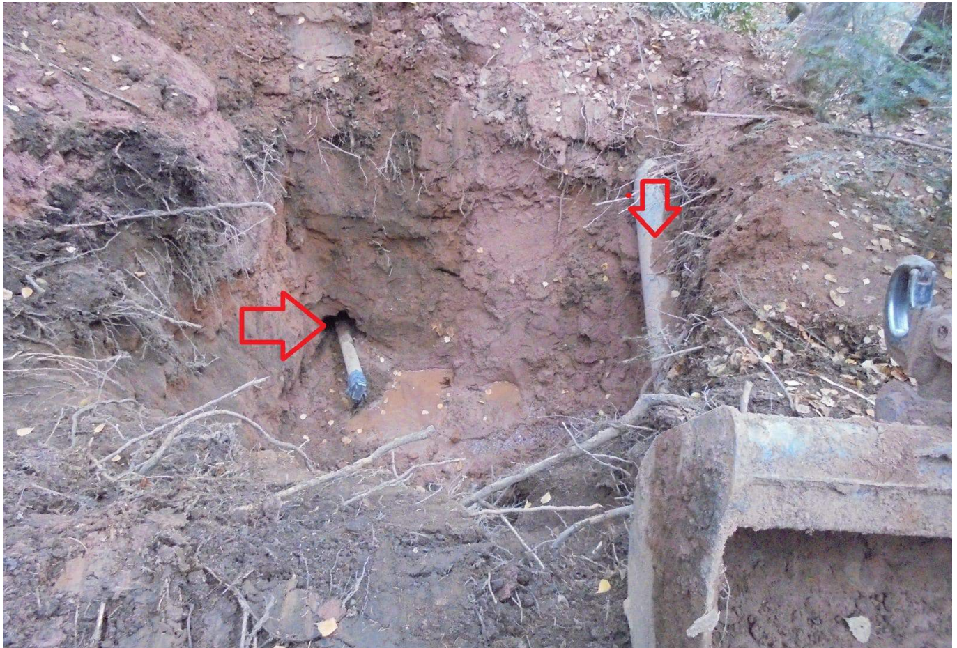
Links kommt die Bohrung von unten zum Holzabfuhrweg, rechts ist das Rohr von oben her bereits drin.
