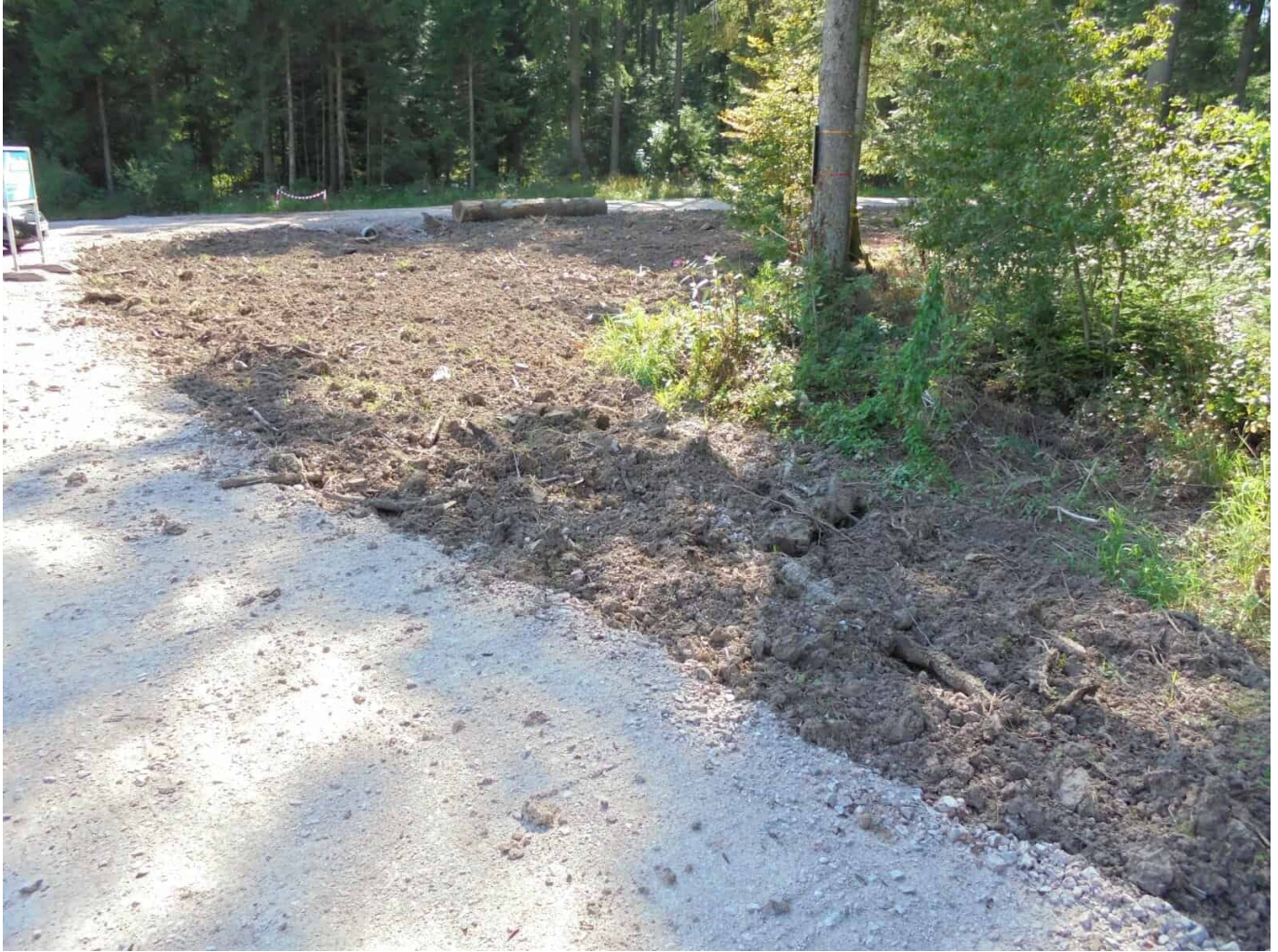
Wegerückbau in einer Kurve. Foto: him
