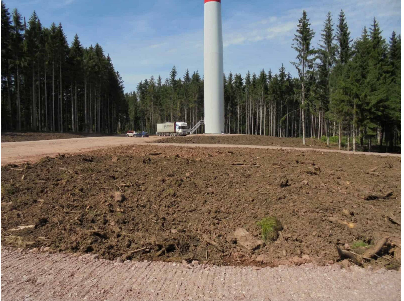
Der tiefengelockerte Boden bei einer der Anlagen. Foto: him
