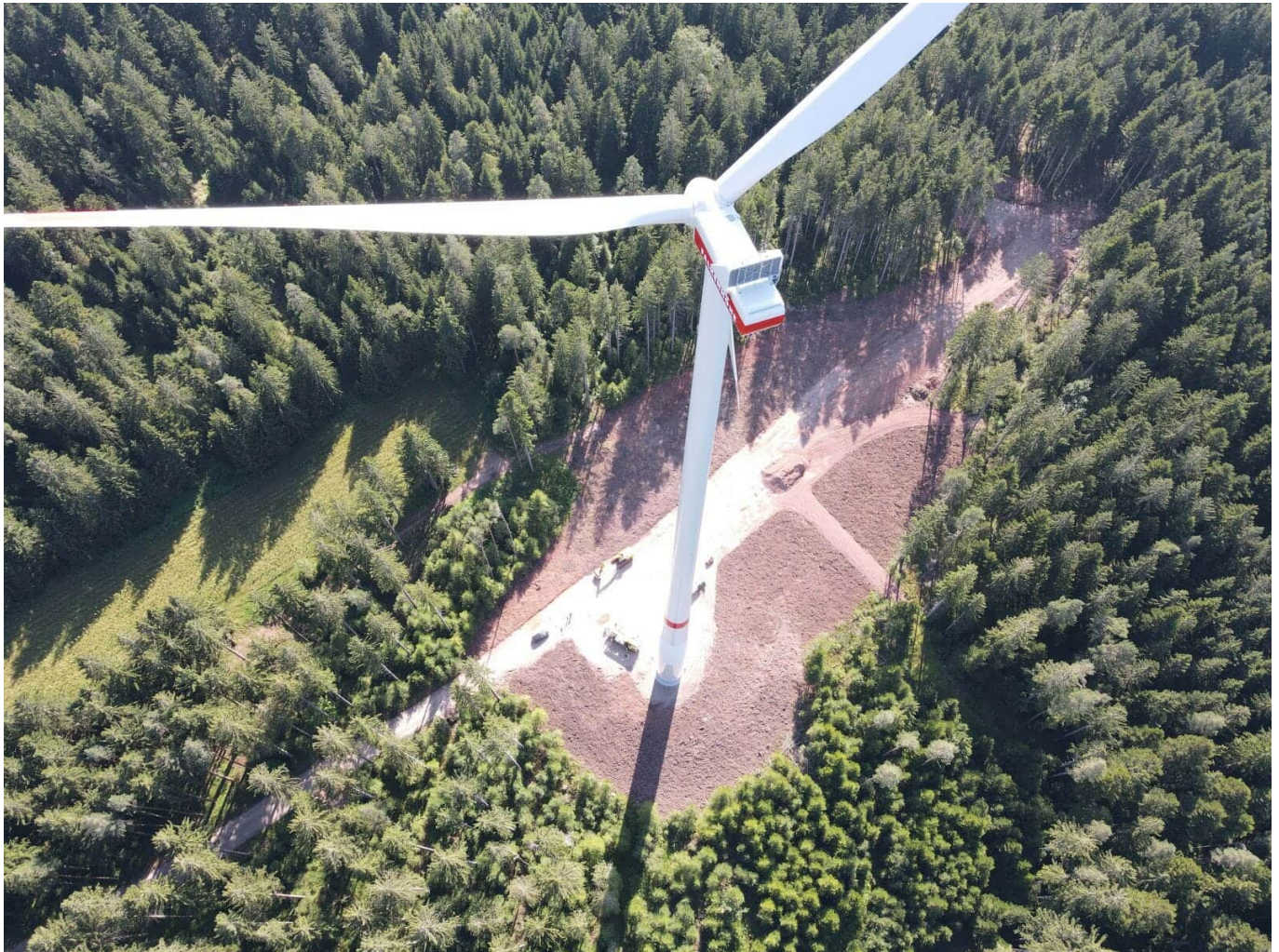
Eine der Windkraftanlagen. Gut zu erkennen, die im vergangenen August aufgelockerten Bereiche um die Anlage und die erforderlichen Wege. Foto: Teckwerke
