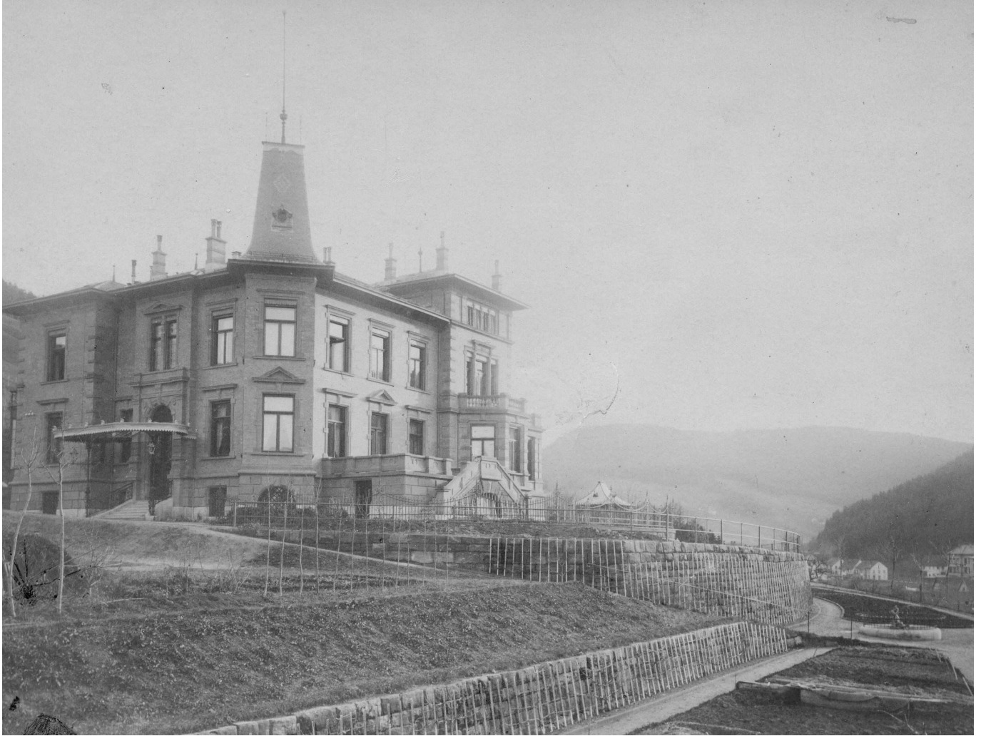
Villa im Bau. Bild: Stadtarchiv
