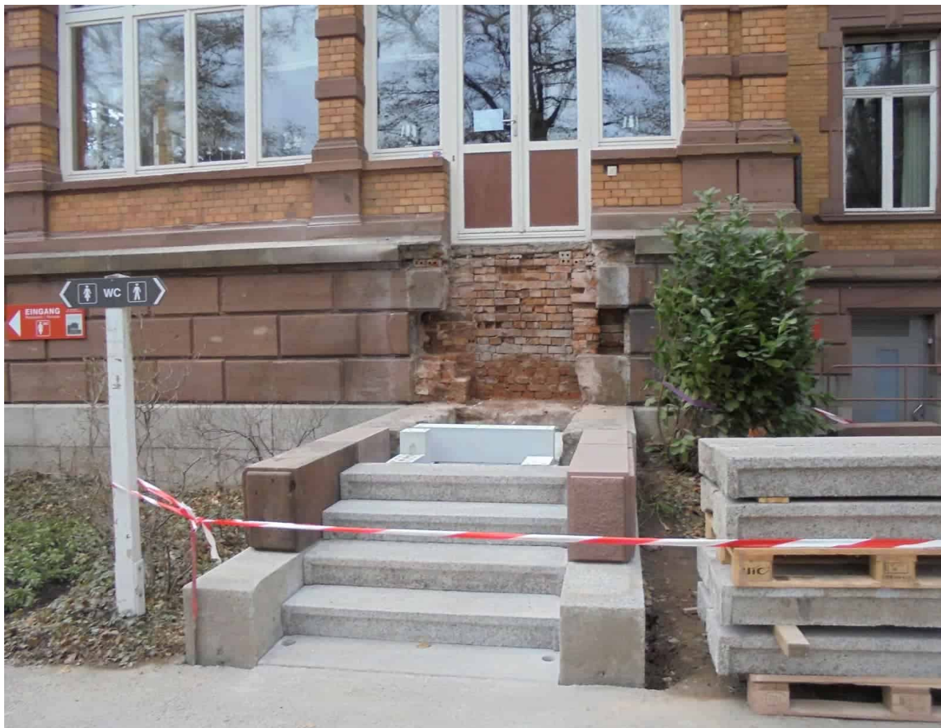
Treppensanierung 2019. Archiv-Foto: him
