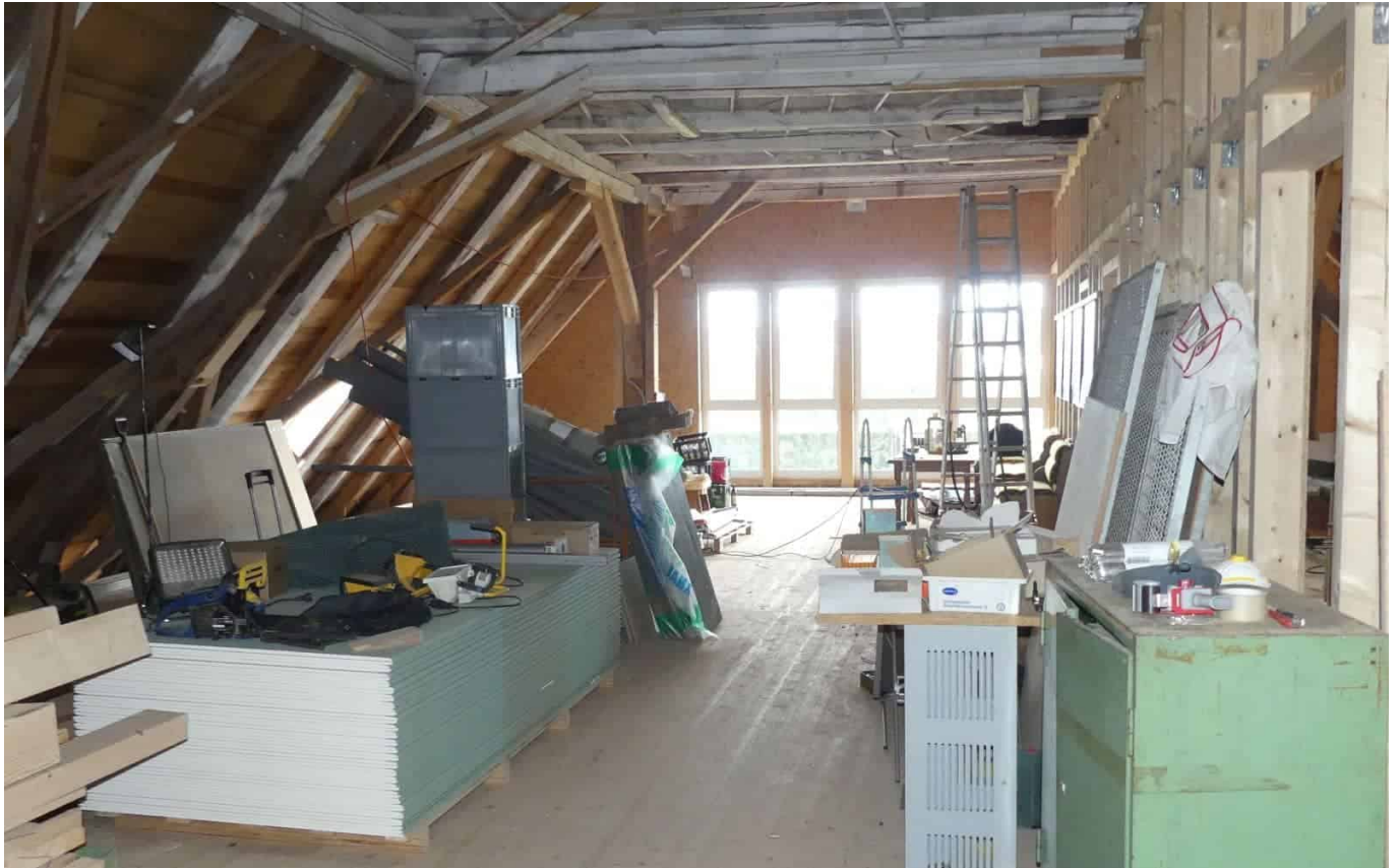
So sah das Dachgeschoss im Januar 2018 aus ...
