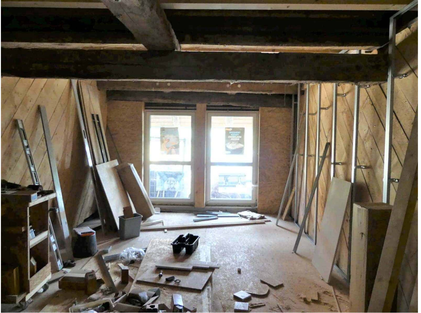
Der Ausbau geht weiter. Foto: him
