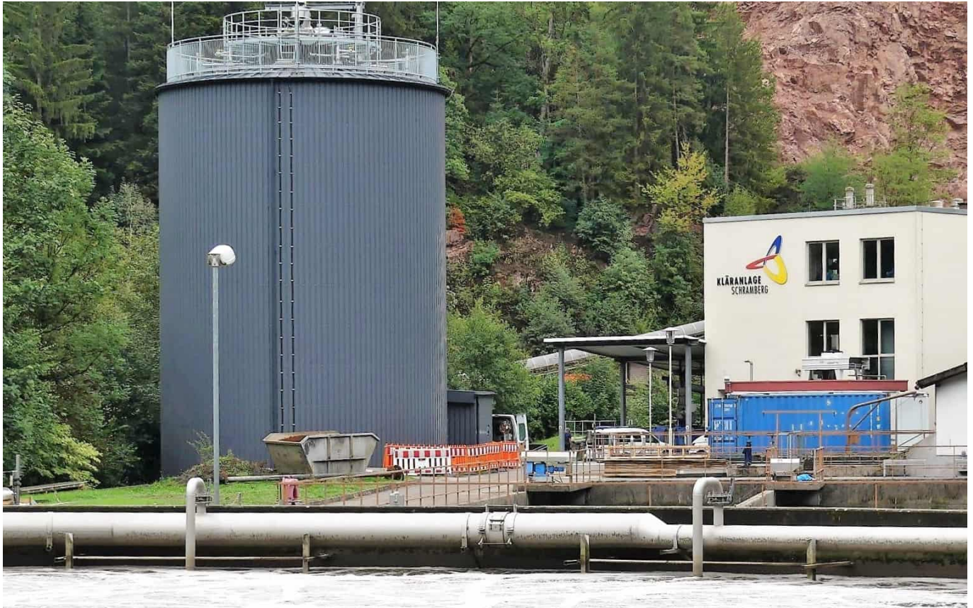
Der neue Faulturm liefert seit ein paar Tagen Gas für ein Blockheizkraftwerk. Foto: him
