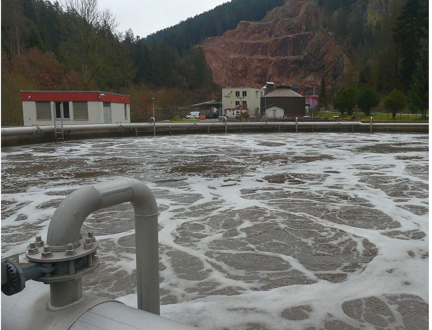
Die Schramberger Kläranlage. Archiv-Foto: him
