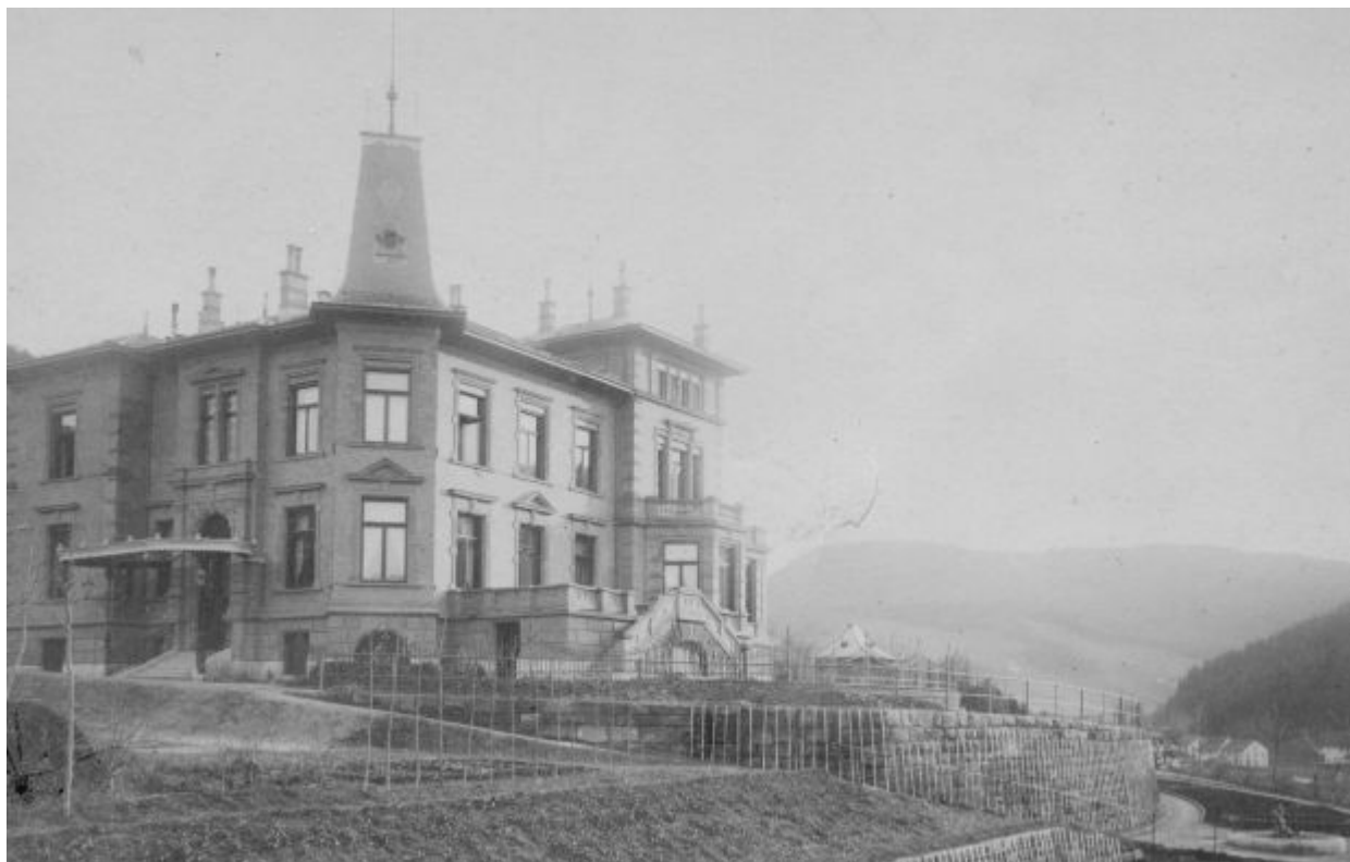
Villa Junghans im Bau.
