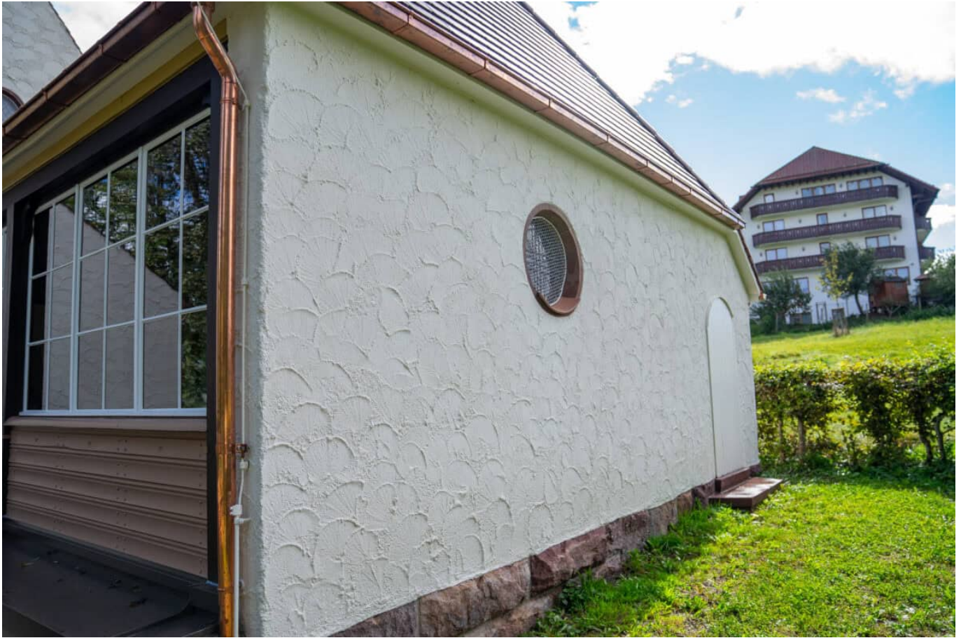
... und nach der Sanierung. Fotos: pm
