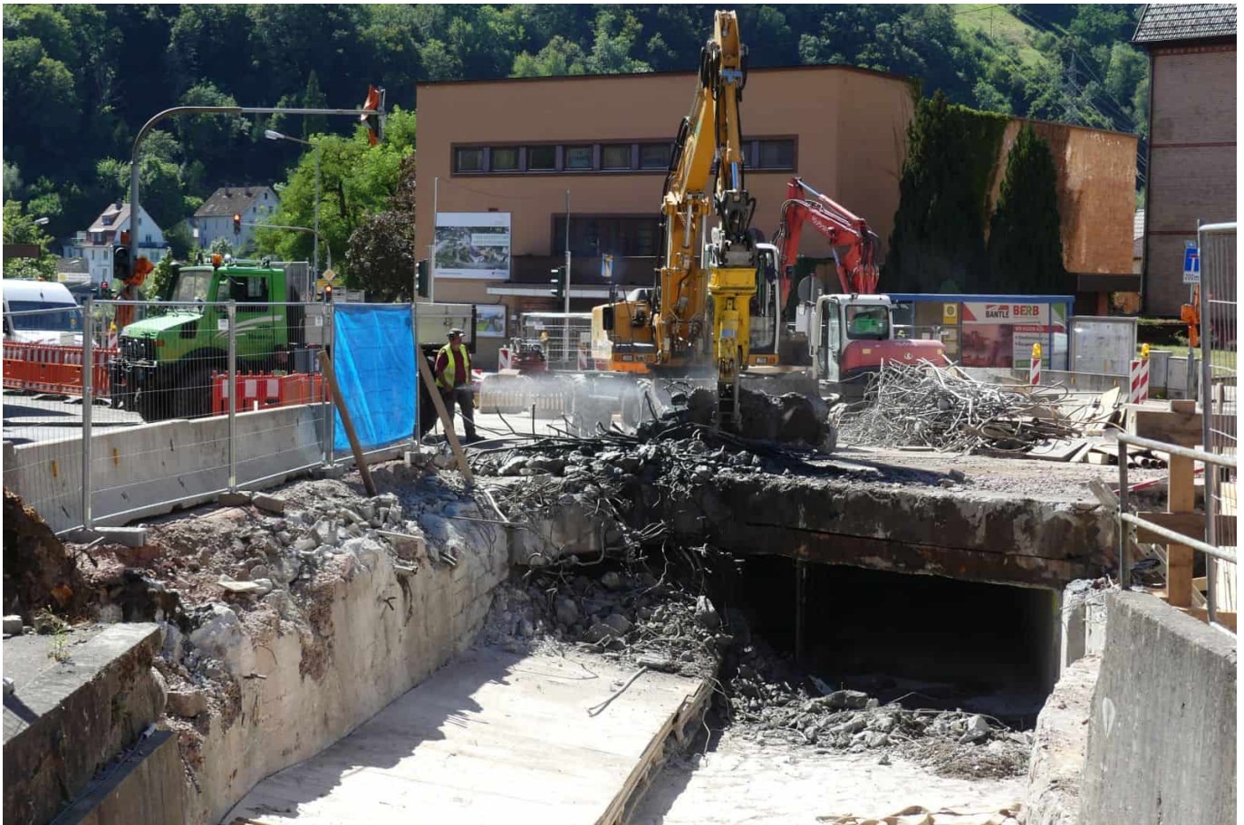
Großbaustelle am Paradiesplatz. Foto: him
