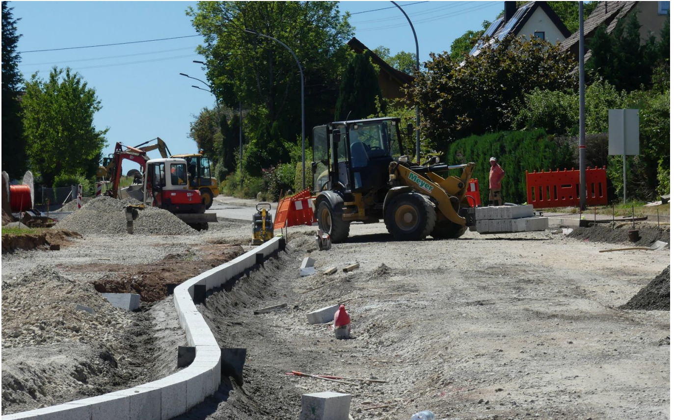
Baustelle beim Schoren. Foto: him
