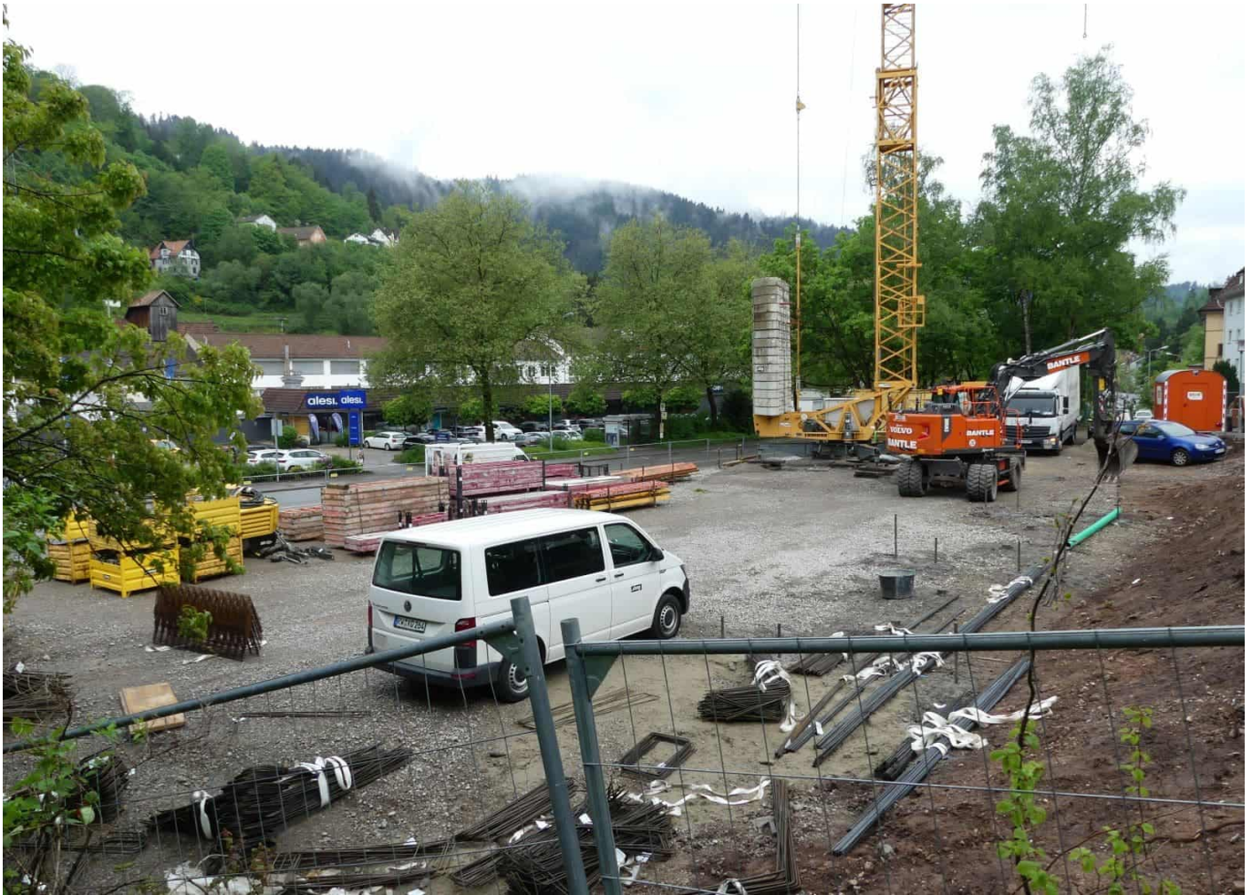
Die Vorbereitungen für das Setzen der Bohrpfähle haben schon begonnen. foto: him
