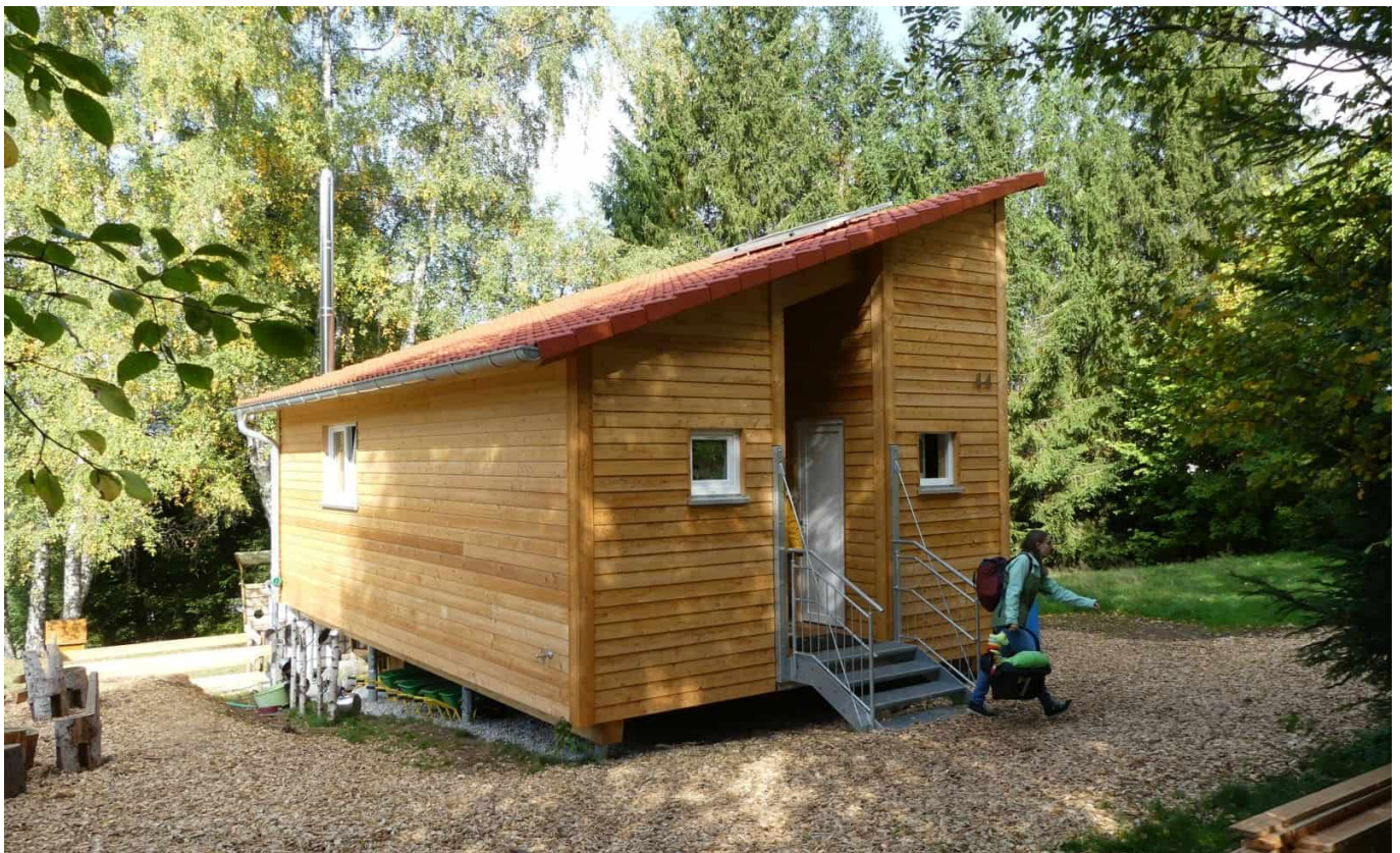
Schmucke Hütte mit Lagerplatz unterm Dach. Foto: him
