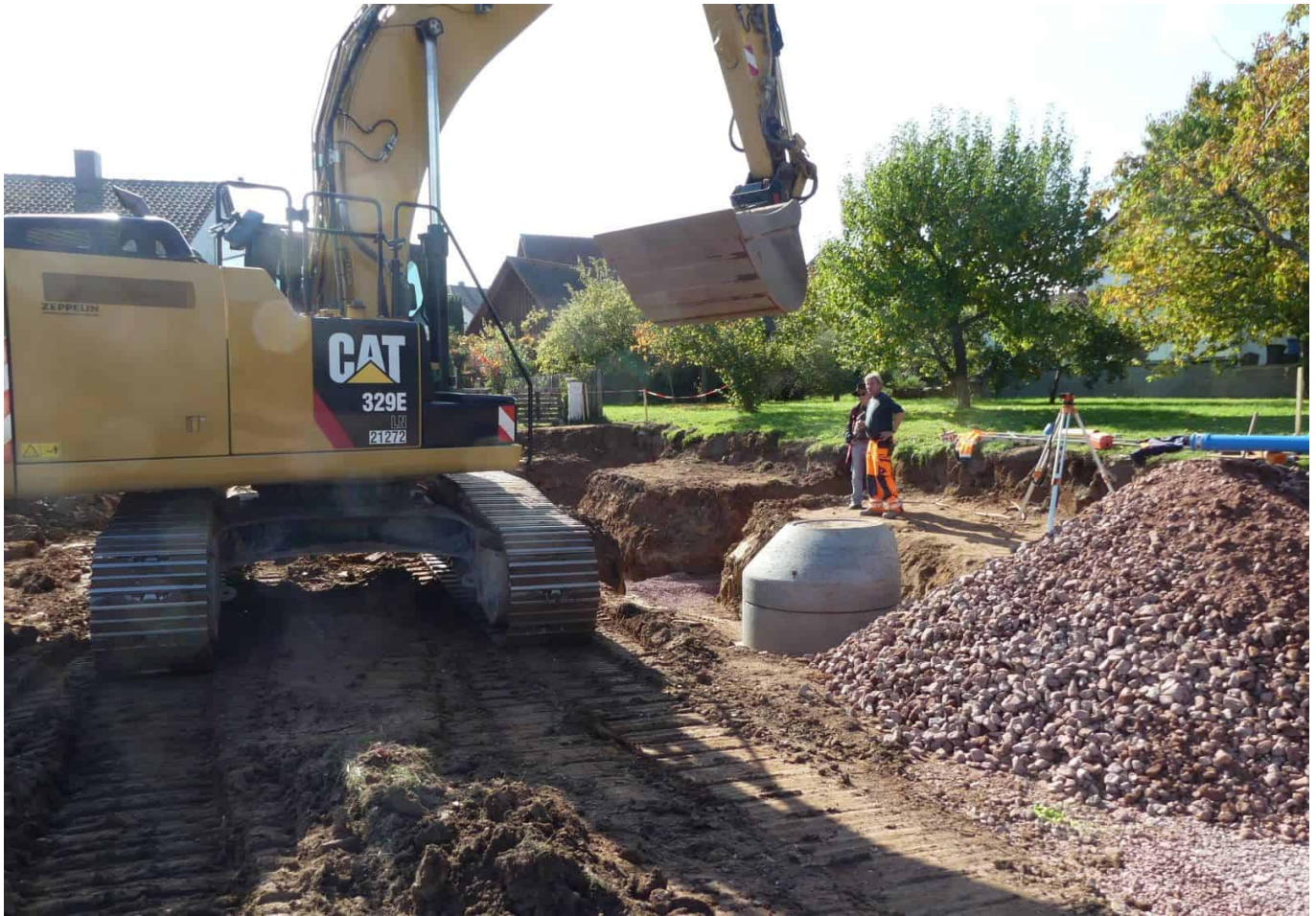
In der Stichstraße liegt der Kanalanschluss bereits. Foto: him
