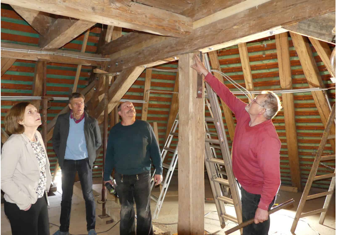
Die Zimmerleute Roland Leinmüller und Michael King zeigen Architekt Bürk und Anita Auer (von rechts), wie sie den Dachstuhl der Kapelle erneuert haben. Foto: him
