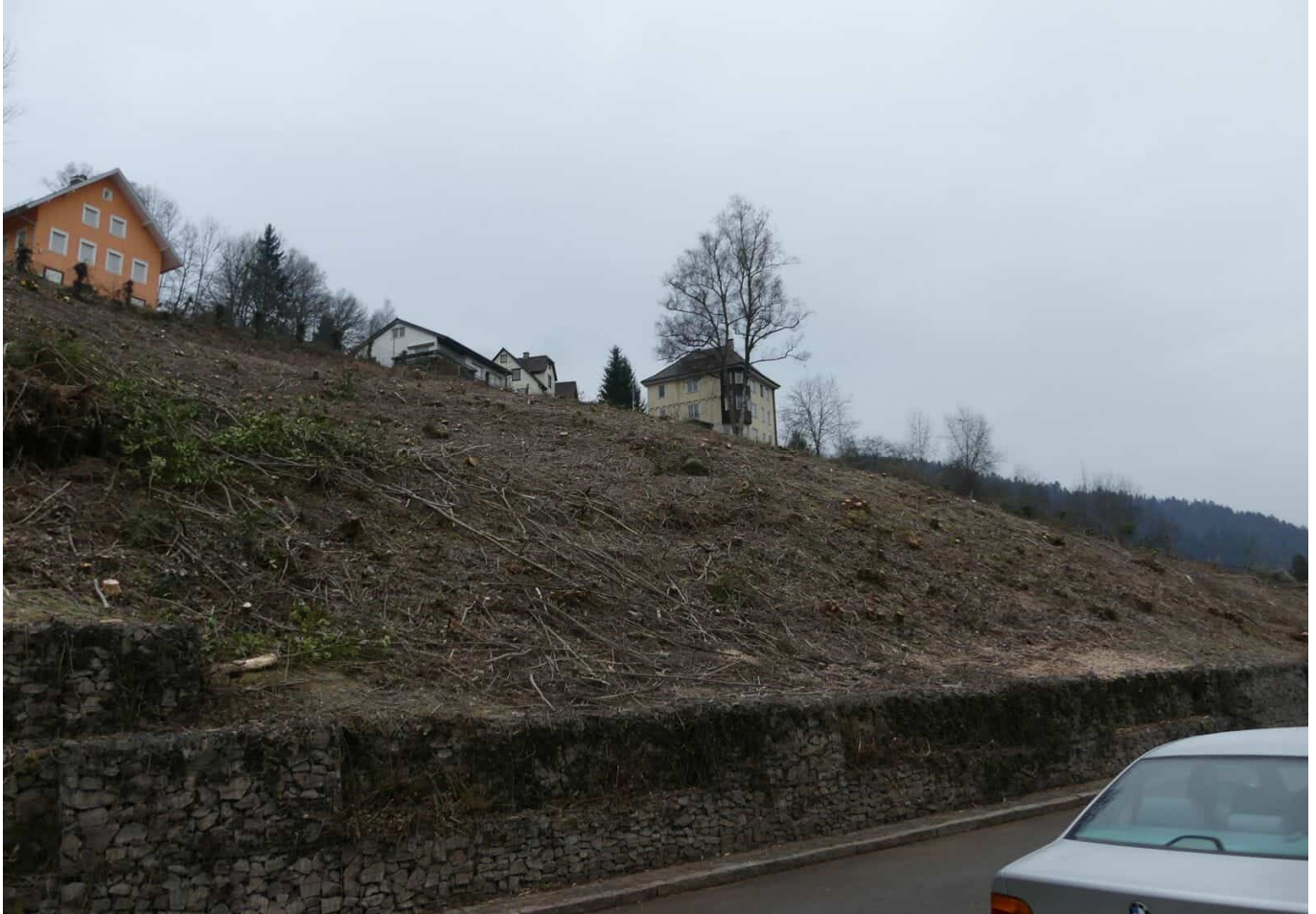
Die Gabionenmauer am unteren Ende eines Teils des Baugrundstücks. Foto: him
