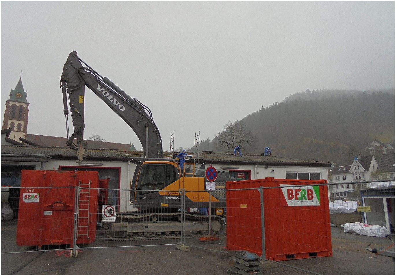
Fachleute räumen das Dach und die Garagen ab.
