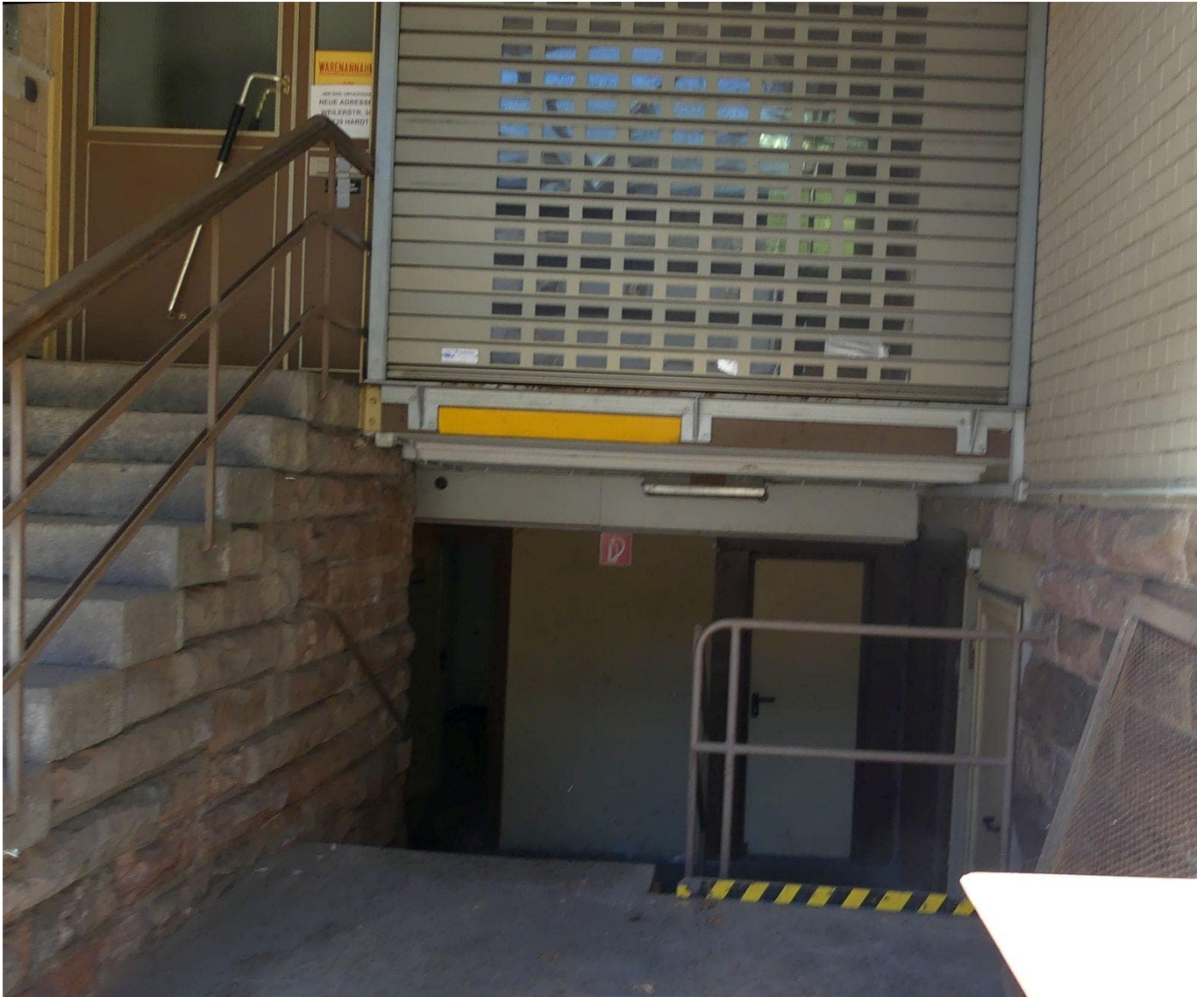
Blick in die frühere Warenannahme.
