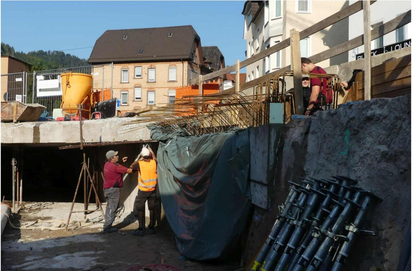
*Im September bereiteten die Bauarbeiter die Betonierung der Bodenplatte vor.*
