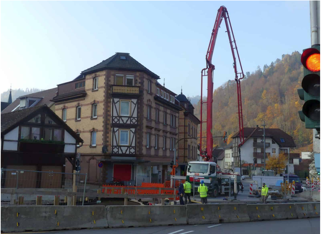
...und am Freitagfrüh wird betoniert.
