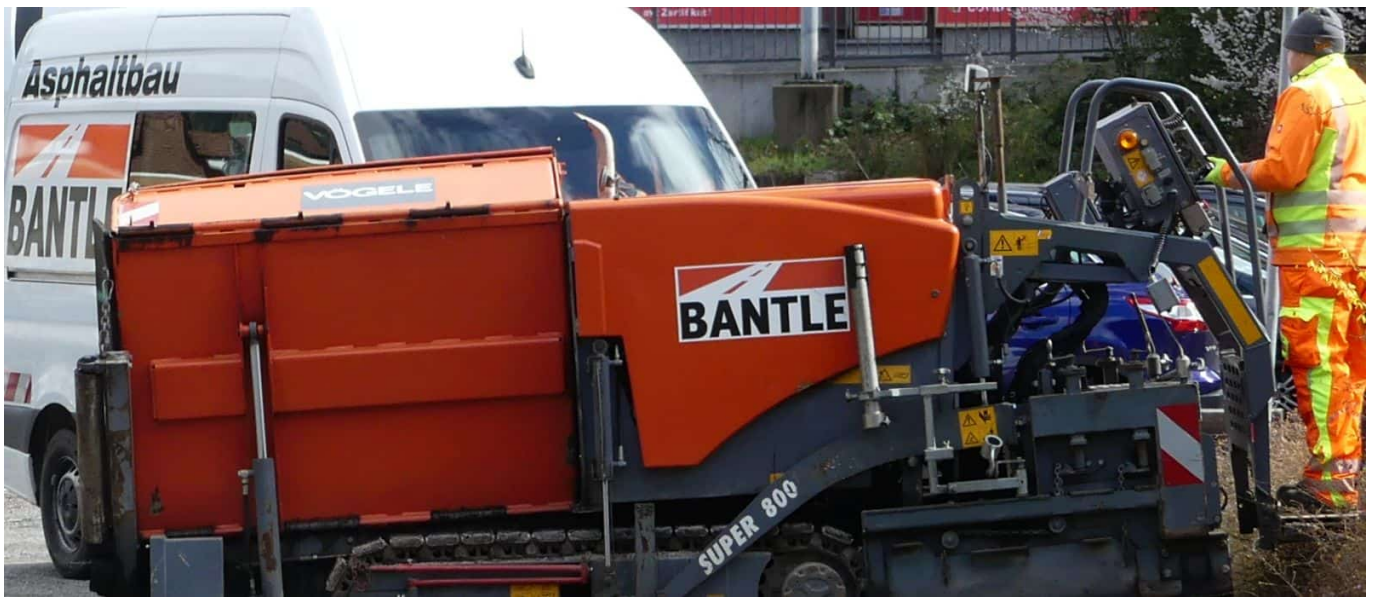
Die Straßenunterhaltungsarbeiten im Stadtgebiet sind angelaufen. Foto: him
