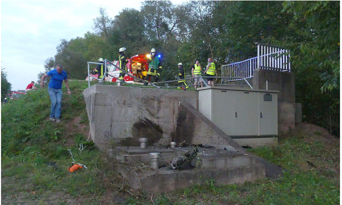
Über diese Mauer des Regenrückhaltebeckens ist der Audi drüber geflogen.
