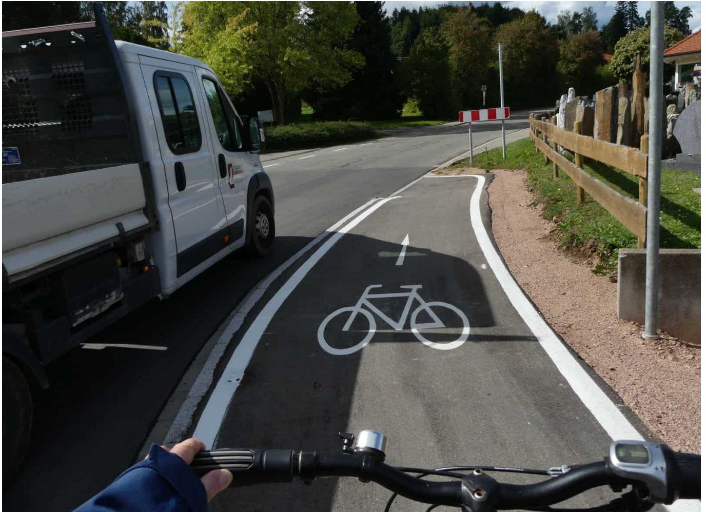
Noch ungut. Das Ende des Radwegs in Sulgen. Hier soll der Radweg ab 2024 weiter gebaut werden. Foto: him
