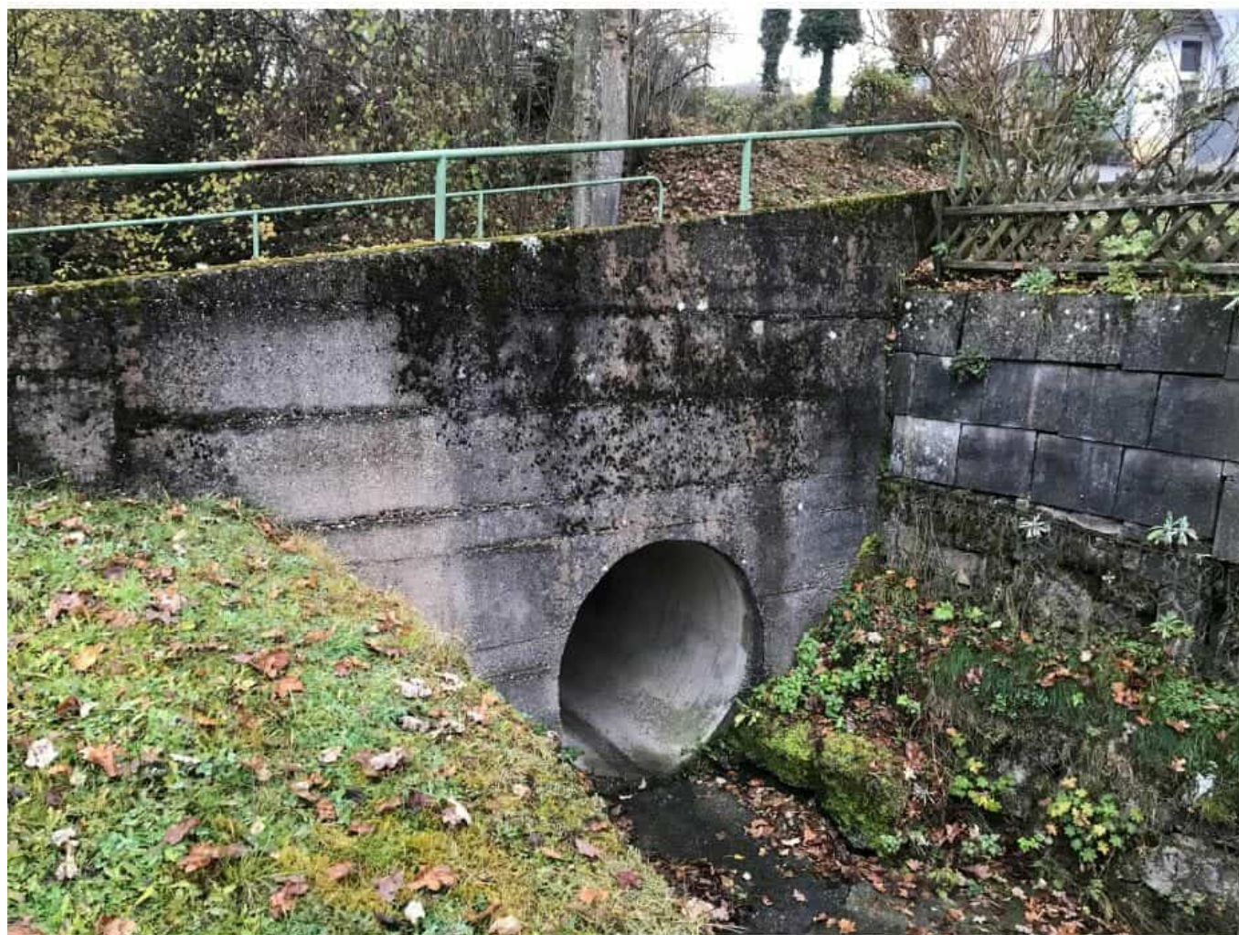
Abb. 3: Bestehendes Brücken-/Durchlassbauwerk „Im Löchle“
