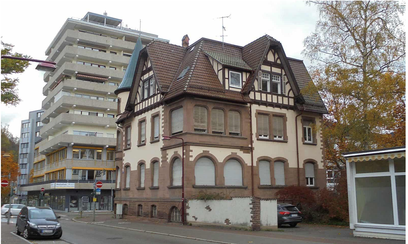
Seit einem Jahr steht das Haus komplett leer. Foto: him
