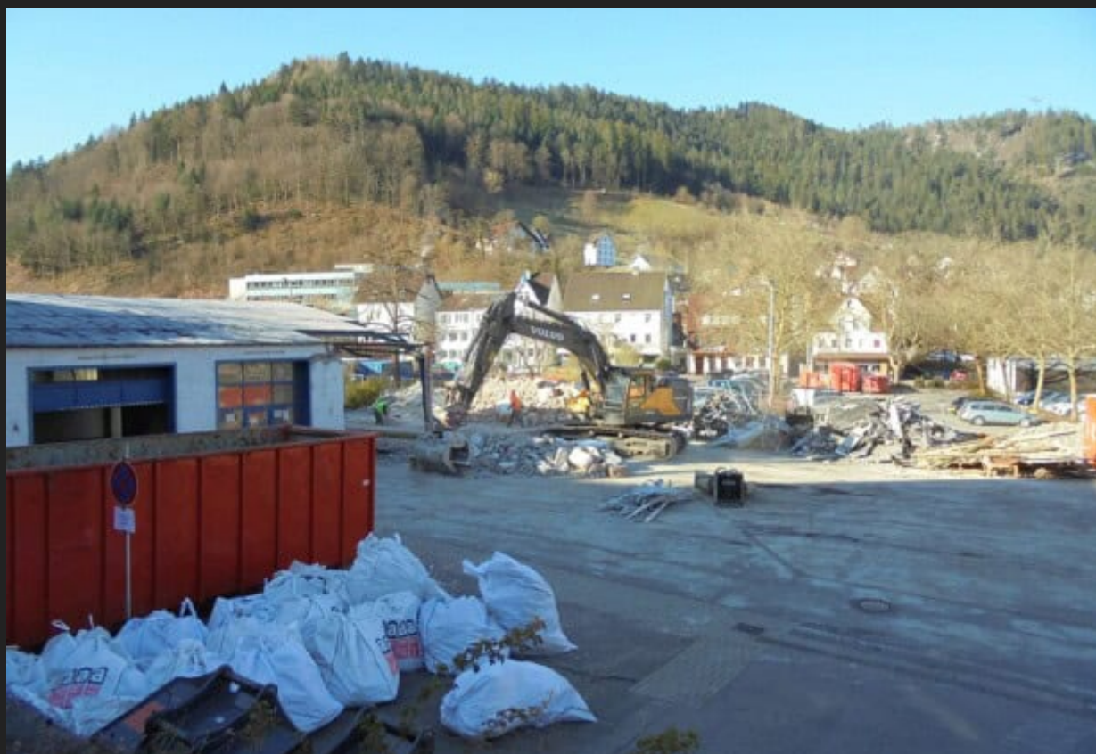
Der Abbruch der Postgaragen ist weitgehend beendet inzwischen. Foto: him
