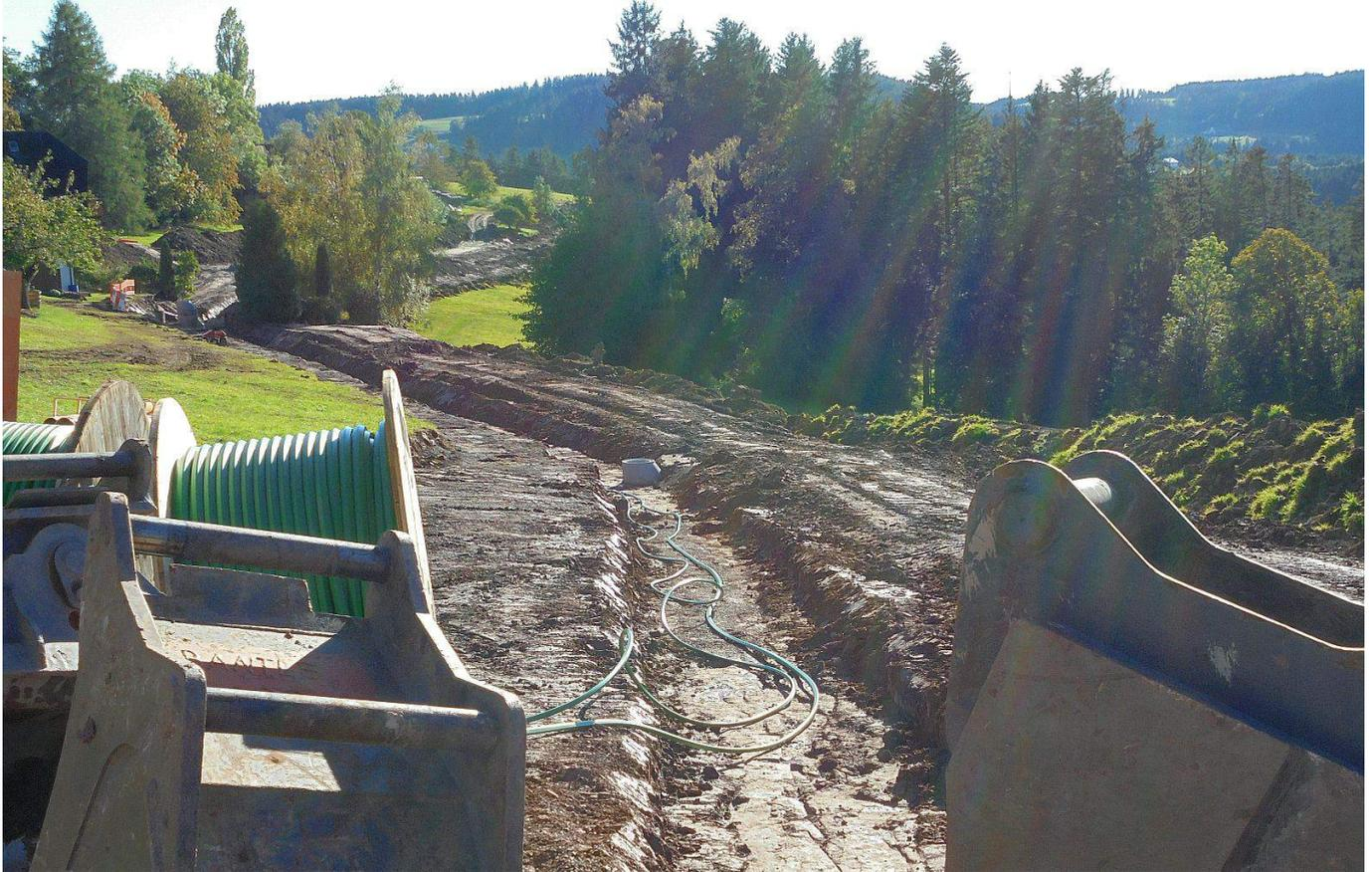
*Hier sind die Kanalrohre schon abgedeckt und es kommen die Leerrohre für Glasfaser in die Erde.*
