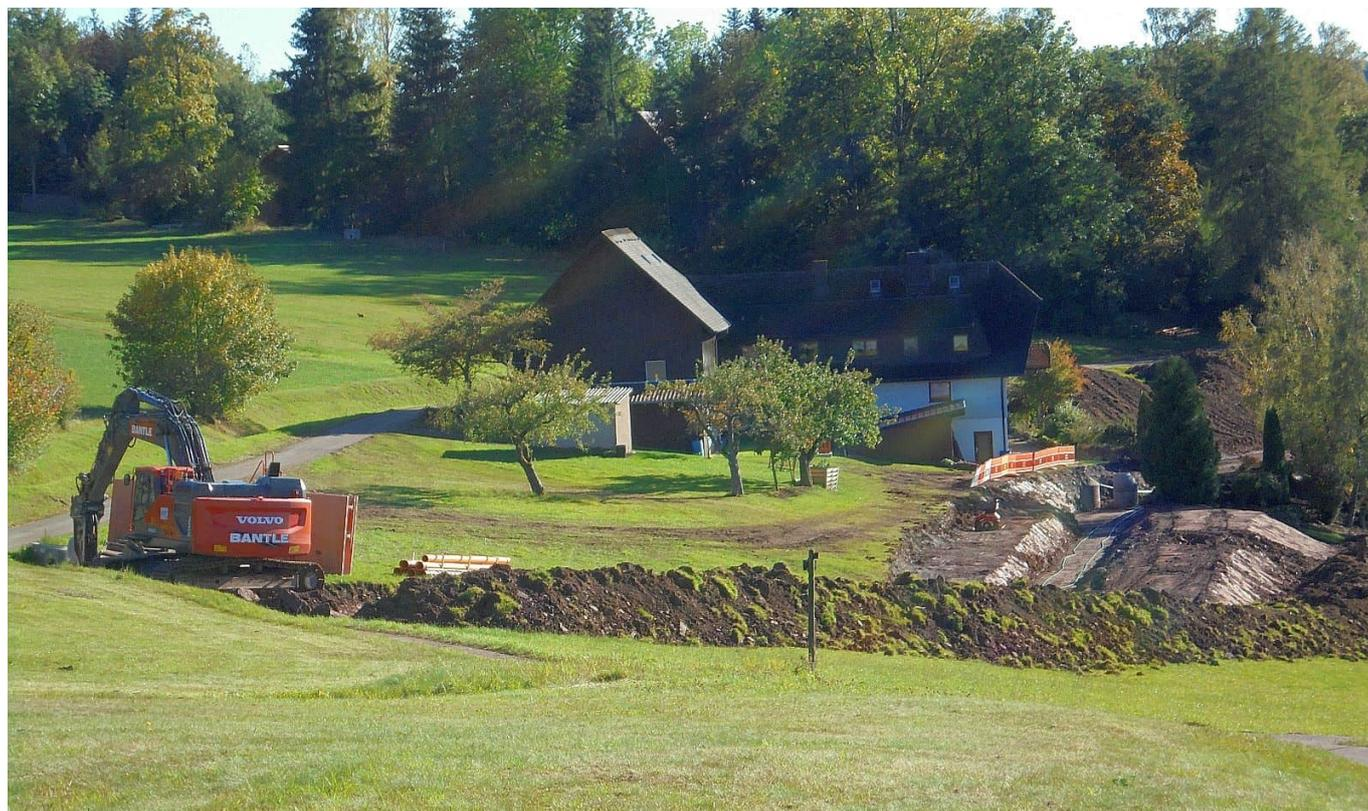
Die 270 Meter lange Pilotbohrung von der Hutneck zum Kirnbach ist fertig. Für die geplante Abwasserleitung für den Außenbereich Hutneck haben Spezialisten mit einer Horizontalbohrmaschine zunächst eine Bohrung mit einem Durchmesser von zehn Zentimeter den steilen Hang hinunter vorgenommen.
