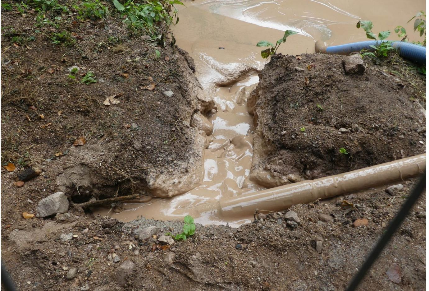
*Bei einer ähnlichen Bohrung beim Sammelweiher: Das Wasser strömt mit Gesteinsmehl aus dem Bohrloch in ein Auffangbecken.*
