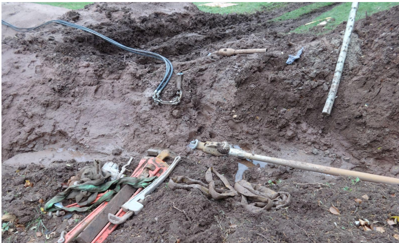
An diese Stange wird das Plastikrohr angehängt...
