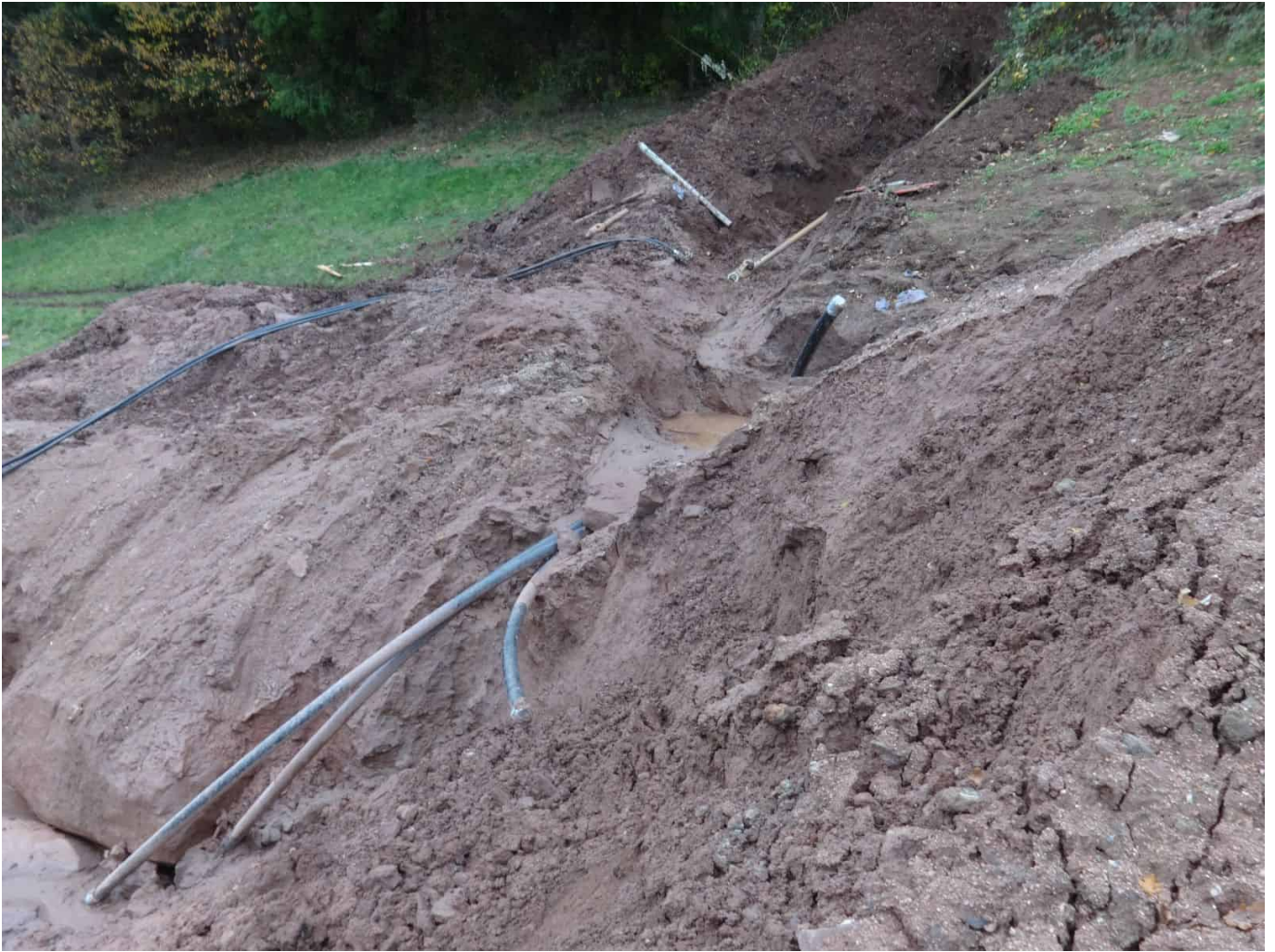
Die Stromkabel sind schon in der Parallelröhre.
