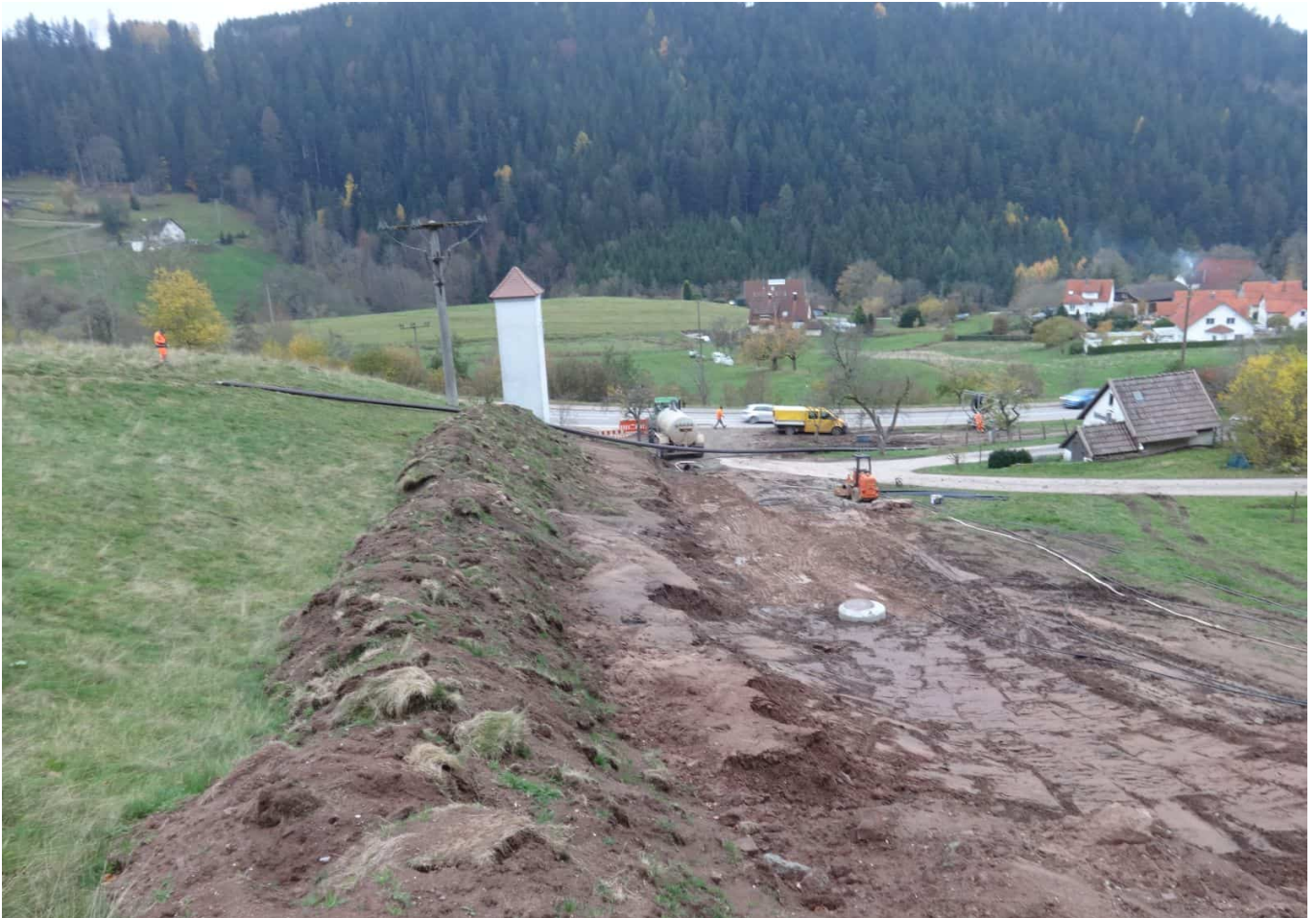
Der Anschluss an das Abwasserrohr im Kirnbach ist fertig.
