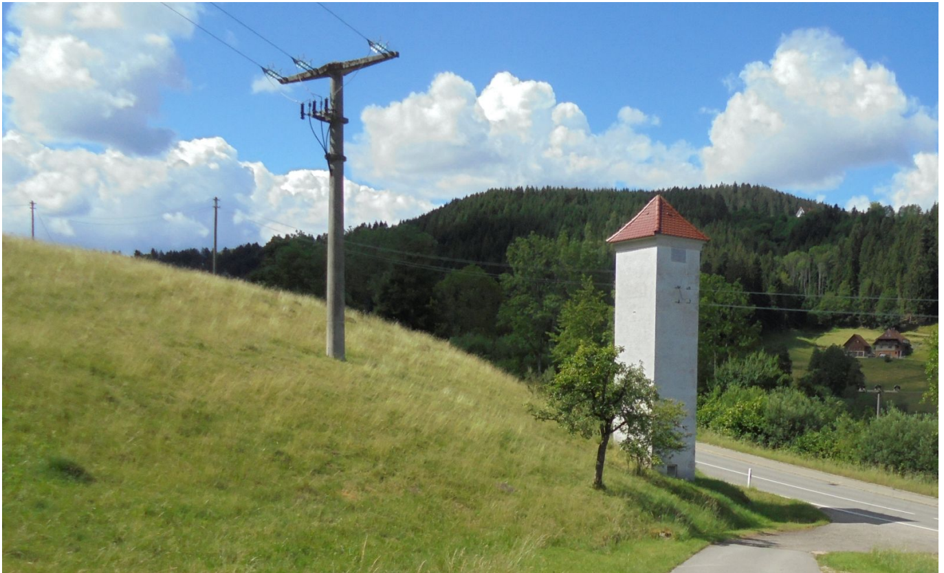
...bis zum Oberen Kirnbach an der Landstraße nach Hardt geführt und dort an das bestehende Abwasserkanalrohr angebunden werden. Fotos: him
