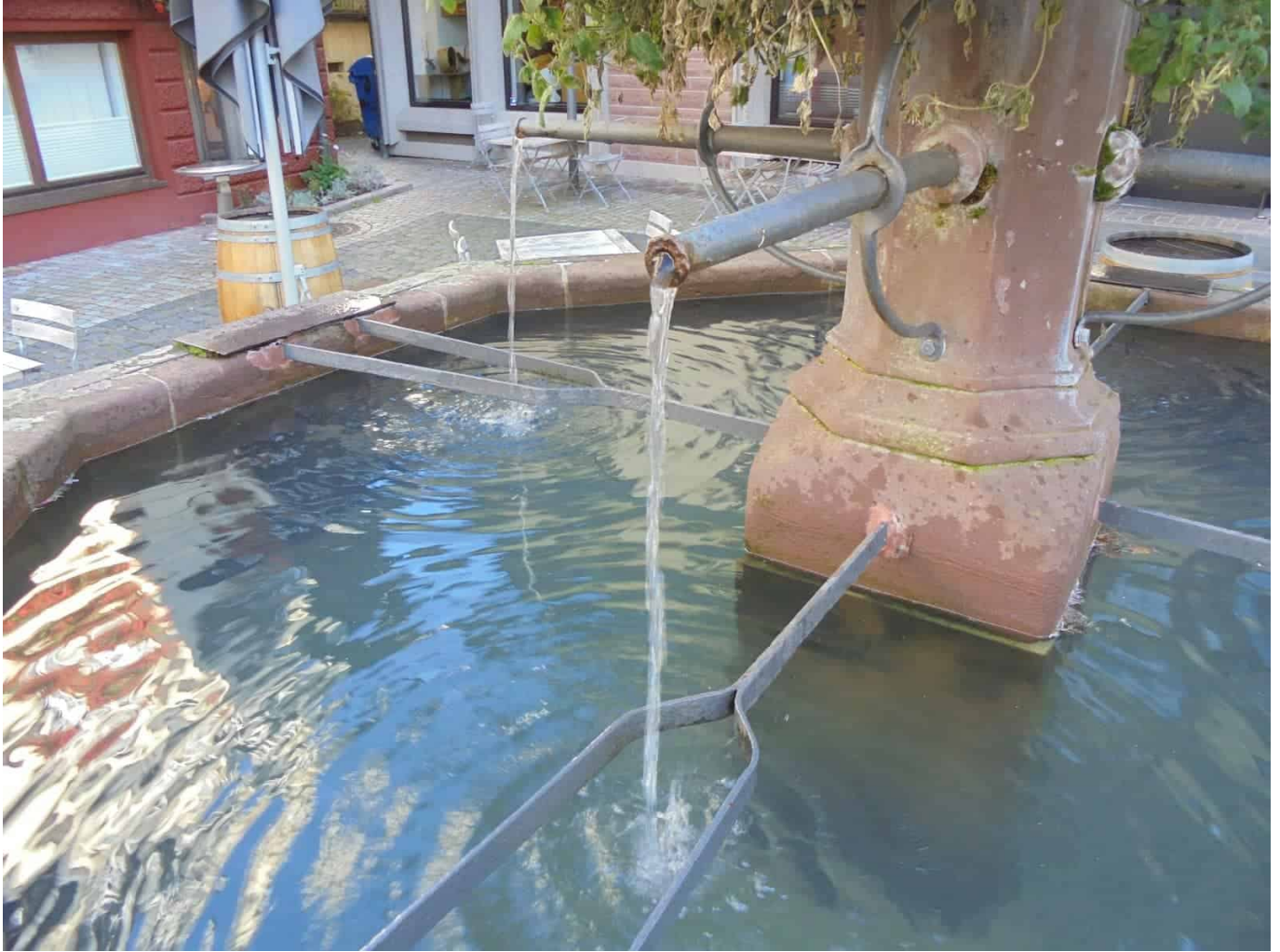
Nach dem „Bohrtreffer“ im Oktober 2020 kam das Wasser getrübt aus der Leitung
