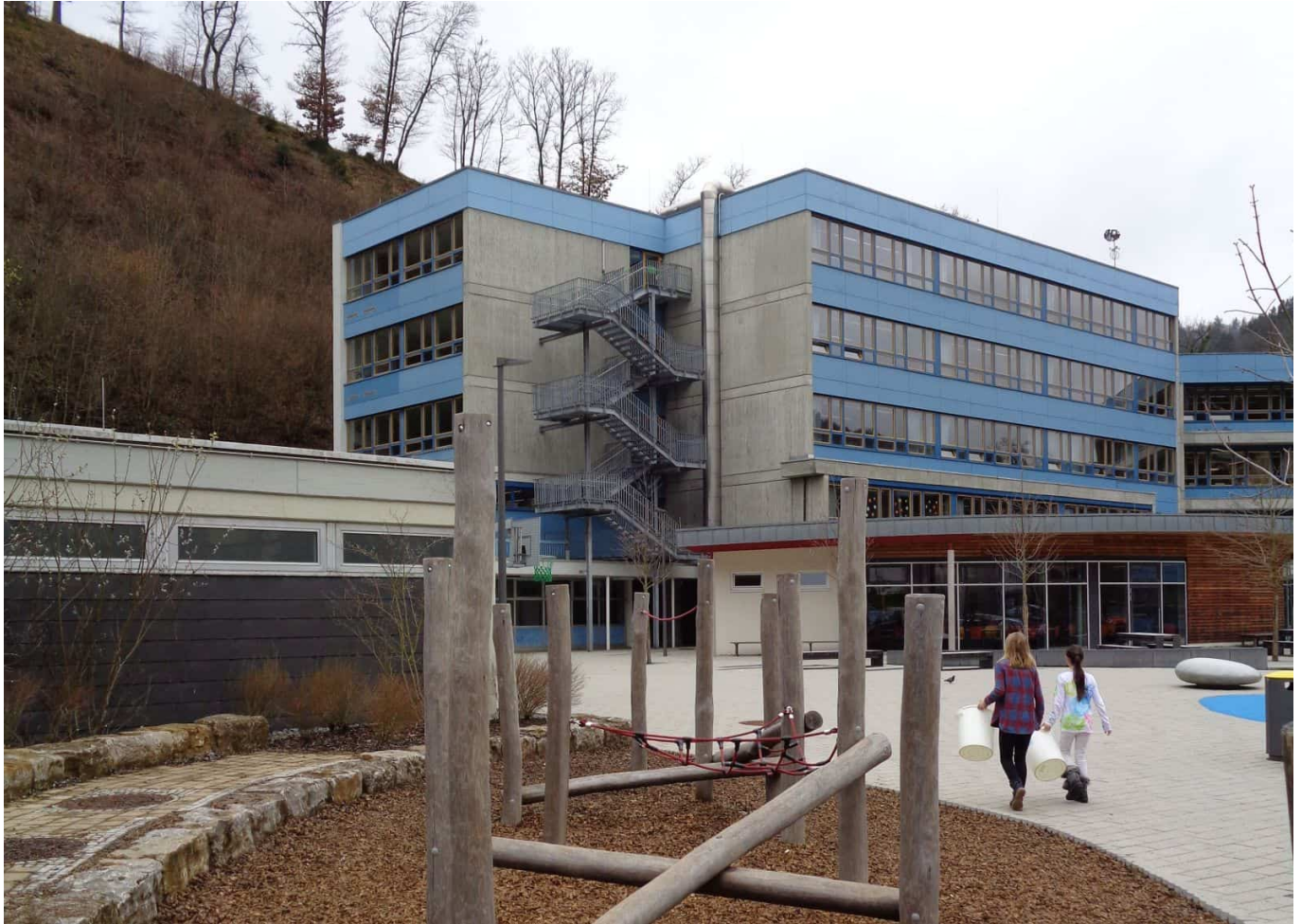
Eine der ersten Arbeiten war denn auch der Anbau sinnvoller Nottreppen. Archiv-Foto: him
