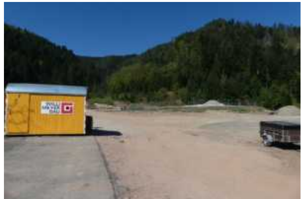
Weitgehend Ruhe auf der Baustelle.
