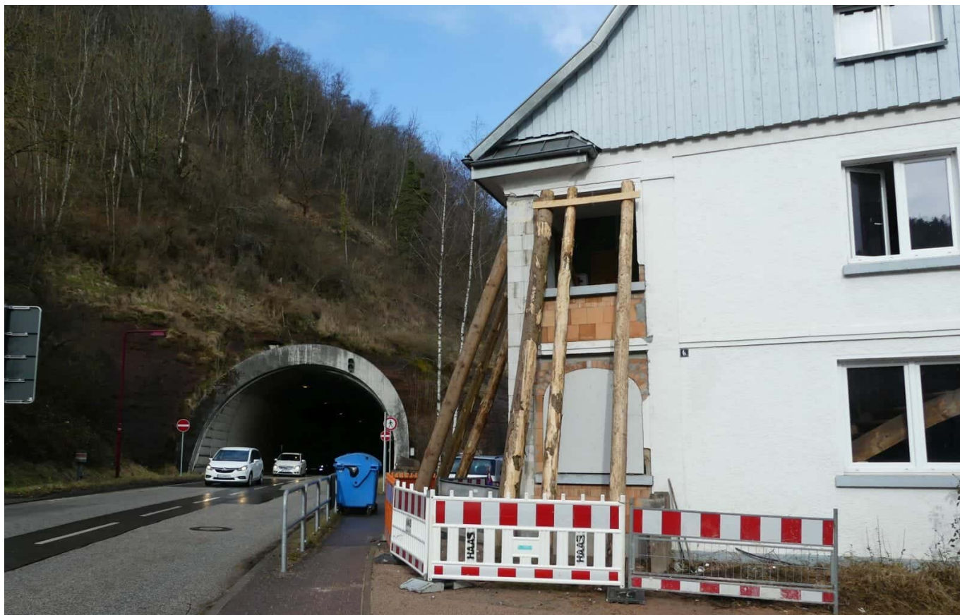
Die Mauer ist fertig. Foto: him
