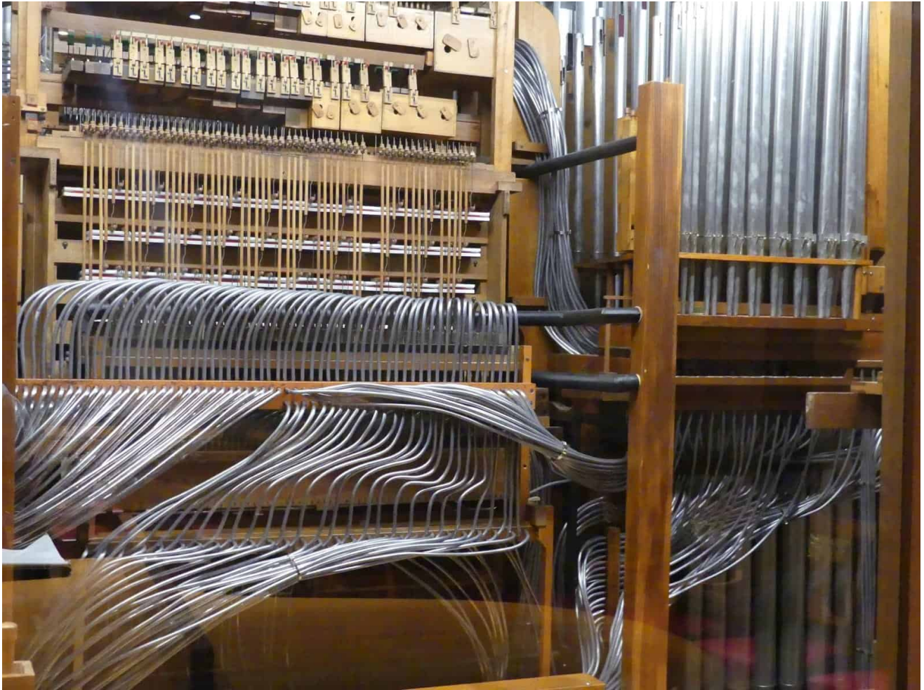
Durch die Rohre kommt die Luft zur Steuerung der Ventile.
