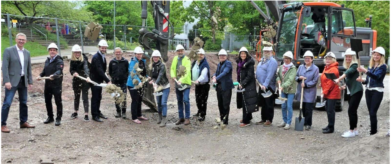
Eine große Schar von Gästen beteiligte sich am 1. Spatenstich für den neuen Kindergarten an der Bahnhofstraße. Architekt Stefan Kamm (8. von links) und Oberbürgermeisterin Dorothee Eisenlohr (7. von links) hatten das Projekt vorgestellt. Archiv-Foto: him
