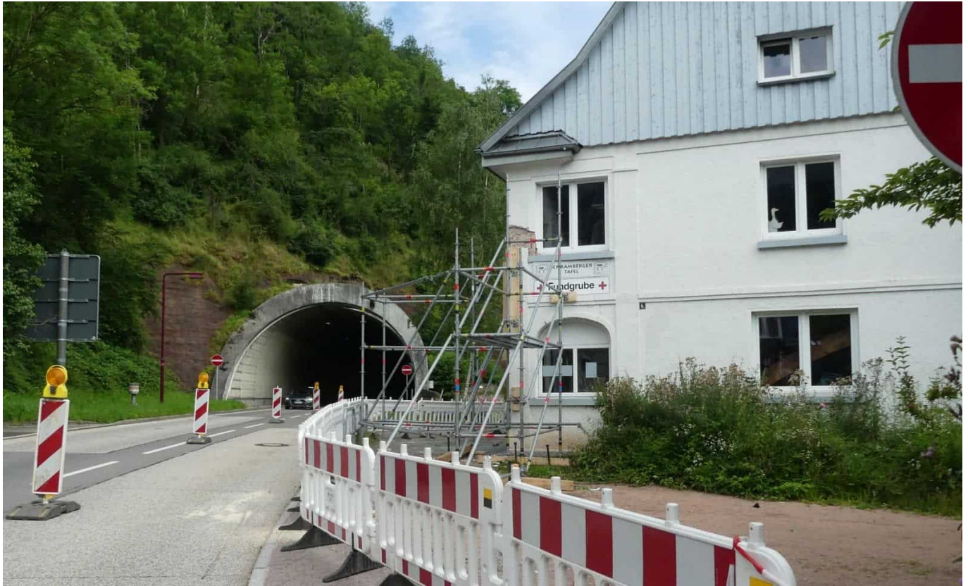
Stark beschädigt: Haus Geißhaldenstraße 6 nach dem Unfall Ende Juli 2021. Archiv-Foto: him
