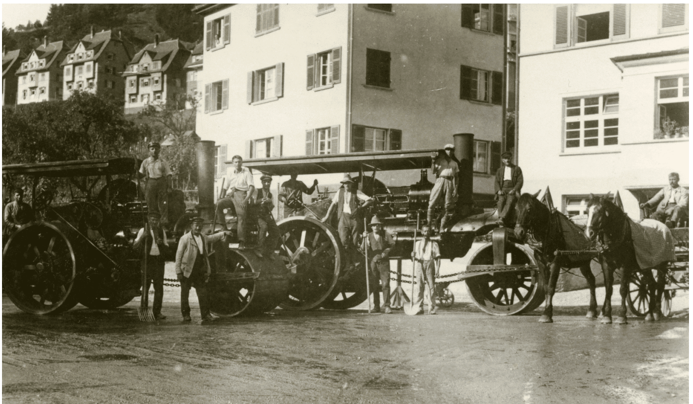
Eine der Junghans'sche Zuglokomotiven als Teerlokomotive im Einsatz bei einer Teerkolonnen am Hammergraben. Fotos: Stadtarchiv Schramberg
