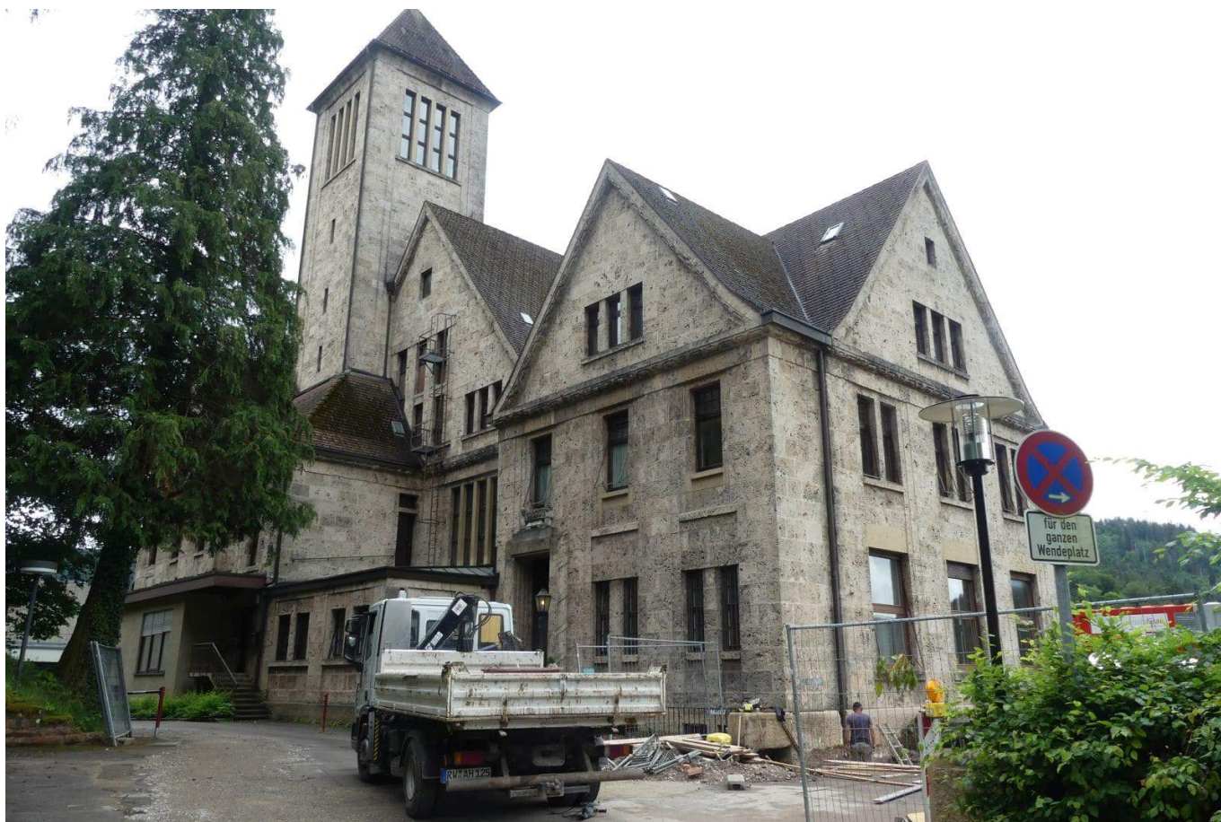
Die Sanierungsarbeiten begannen schon 2018. Archiv-Foto: him
