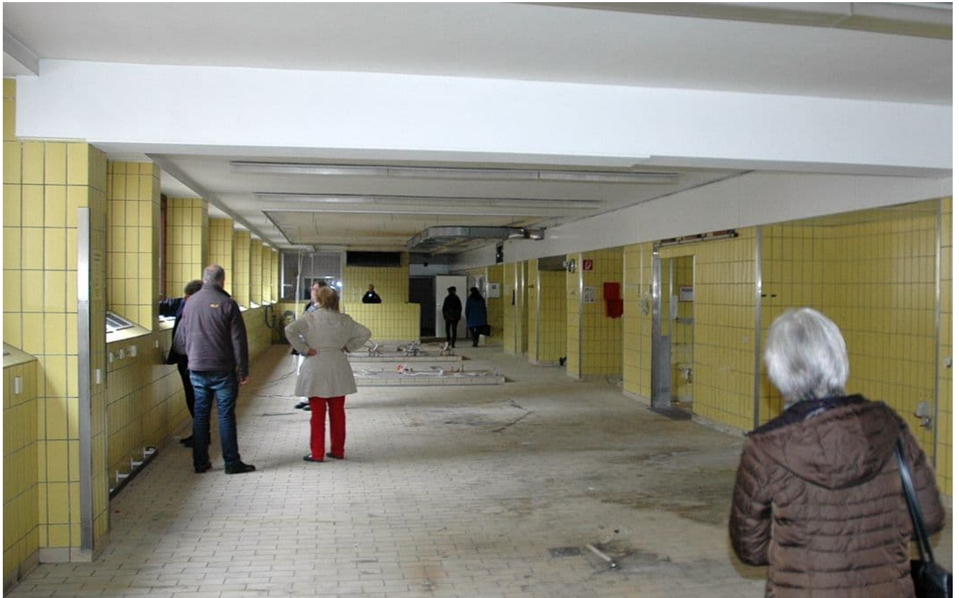
So sah beispielsweise der Großküchenbereich im Krankenhaus aus, nachdem Helios das Haus an die Stadt Schramberg übergeben hatte. Die Bilder entstanden bei einer Besichtigung des Gemeinderats im Jahr 2016. Fotos: him
