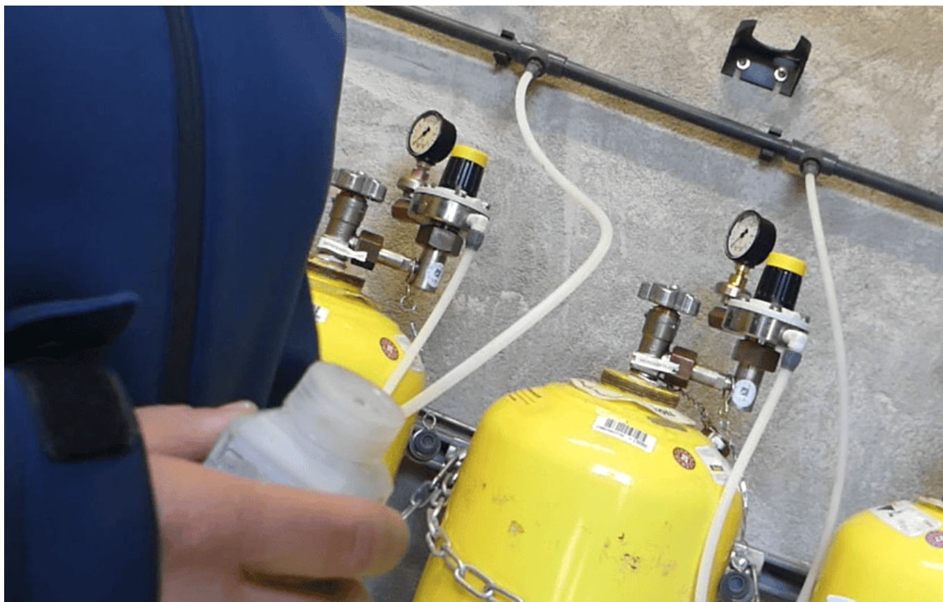
In dem Fläschchen befindet sich Ammoniak, um Chlorgas zu erkennen. Foto: him
