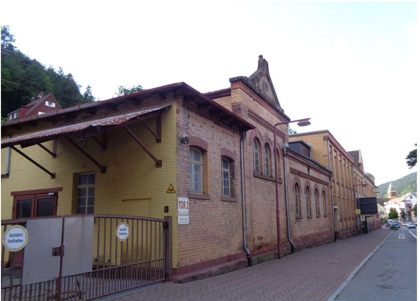
Pfaff-und-Schlauder-Fabrik jetzt ebenfalls im Sanierungsgebiet. Archiv-Foto: him
