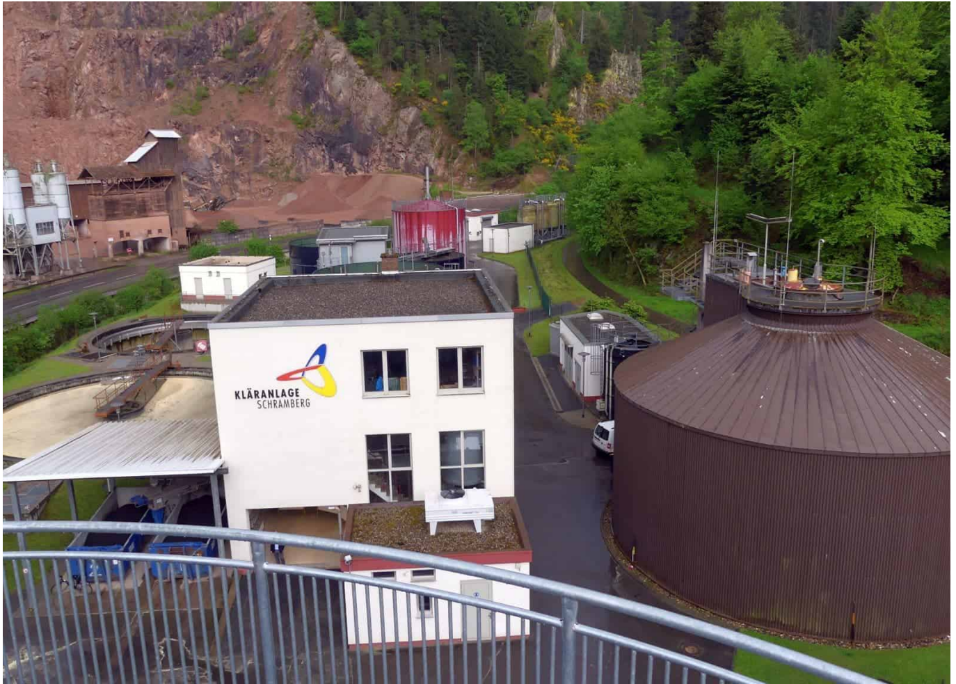
Blick vom neuen auf den alten Faulturm (rechts). Foto: him
