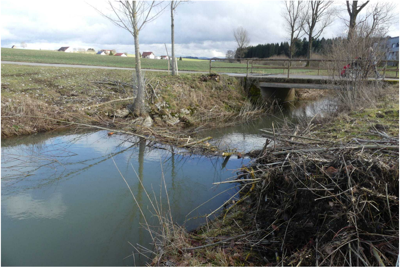
Das Wasser staut sich auf knapp einen Meter.
