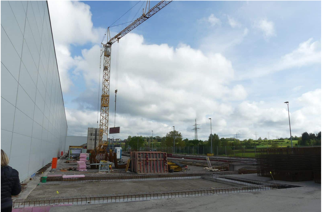
Bei SW entsteht ein Anbau für die Montagehalle. Foto: him
