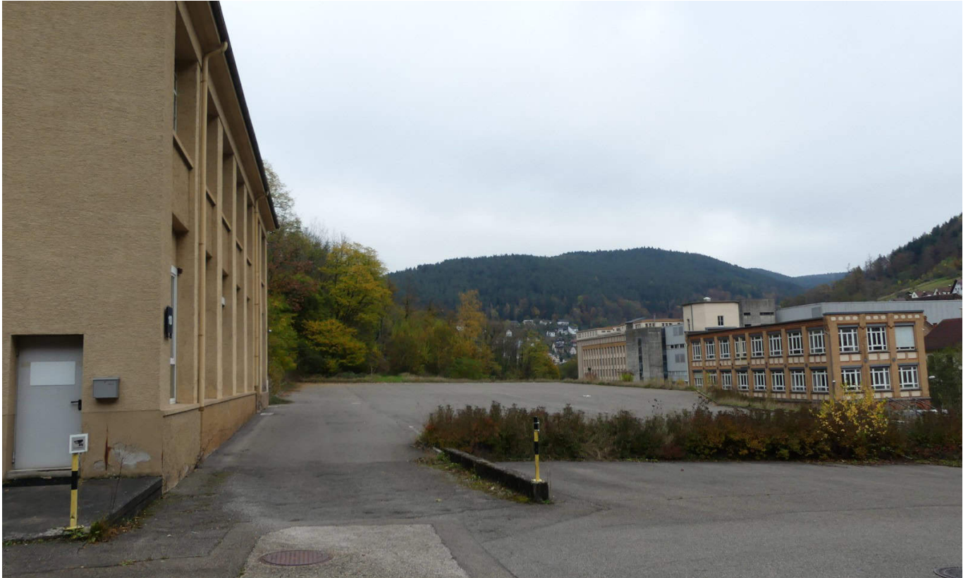
Der Parkplatz direkt neben Bau 10 ist baurechtlich der Szene 64 zugeordnet. Foto: him
