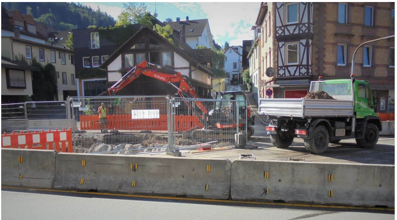
Am Paradiesplatz wird weiter gebaggert. Foto: him
