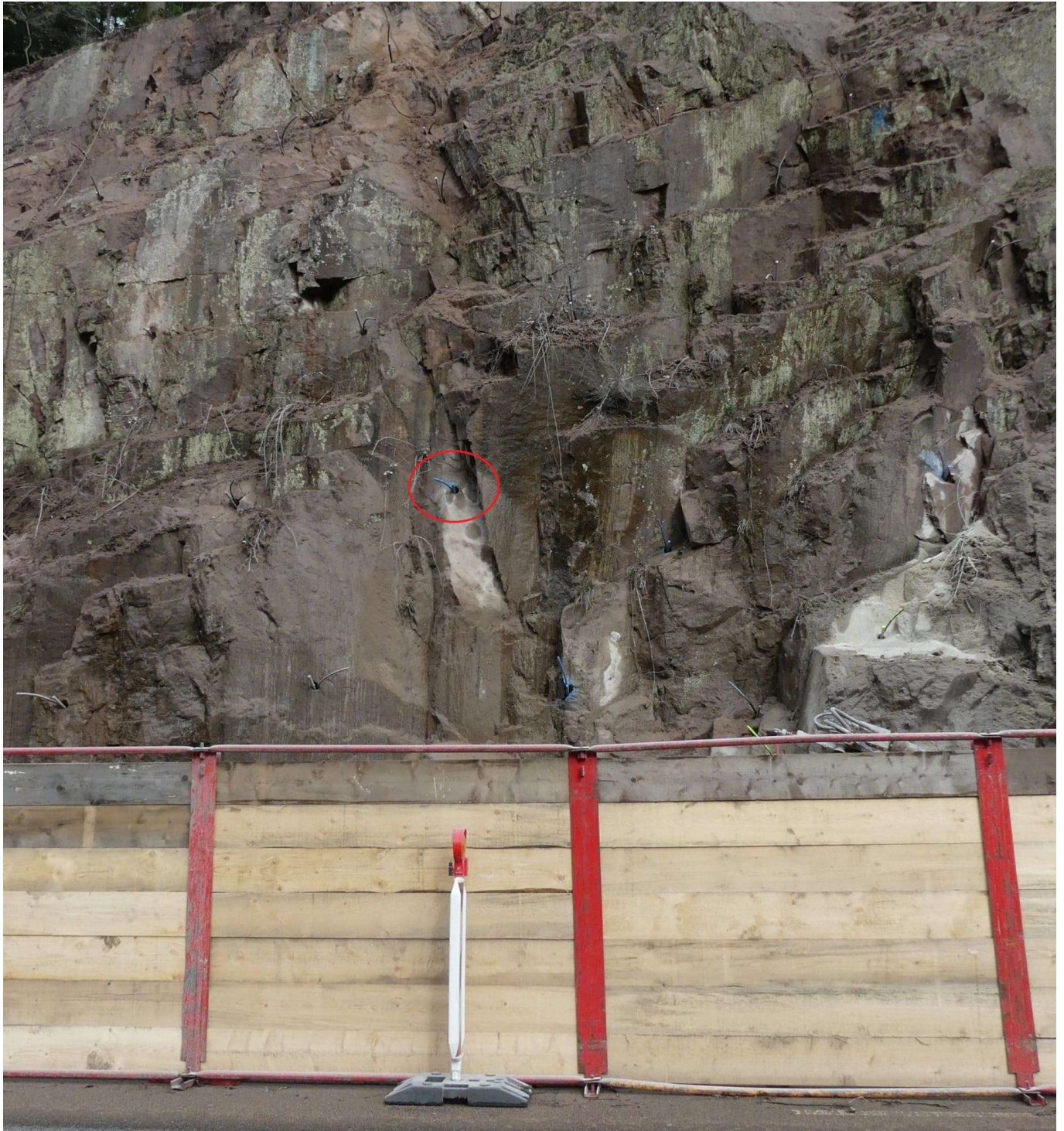
Viele Löcher sind schon gebohrt und die Stahllanker hineingesteckt...
