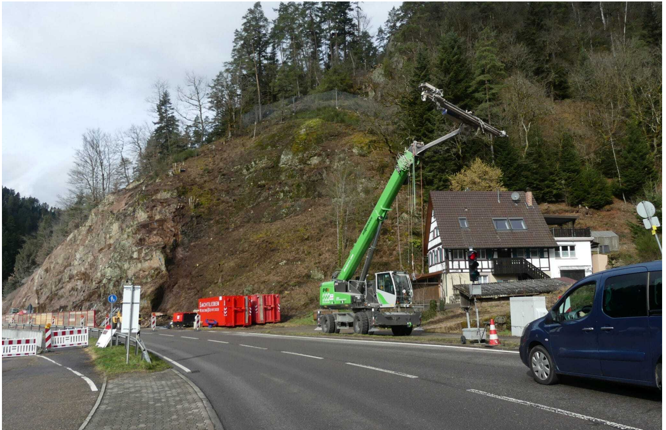
Mit einem an einem Bagger anmontierten Bohrgerät bohren in der Nacht die Mineure die Löcher in den oberen Teil des Felsens.
