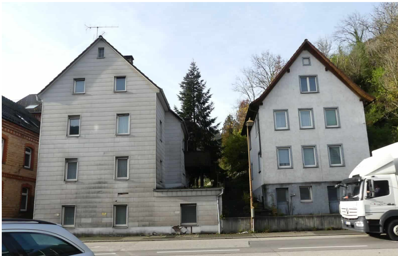
Auch diese beiden Häuser an der Geißhaldenstraße werden abgebrochen. Foto: him
