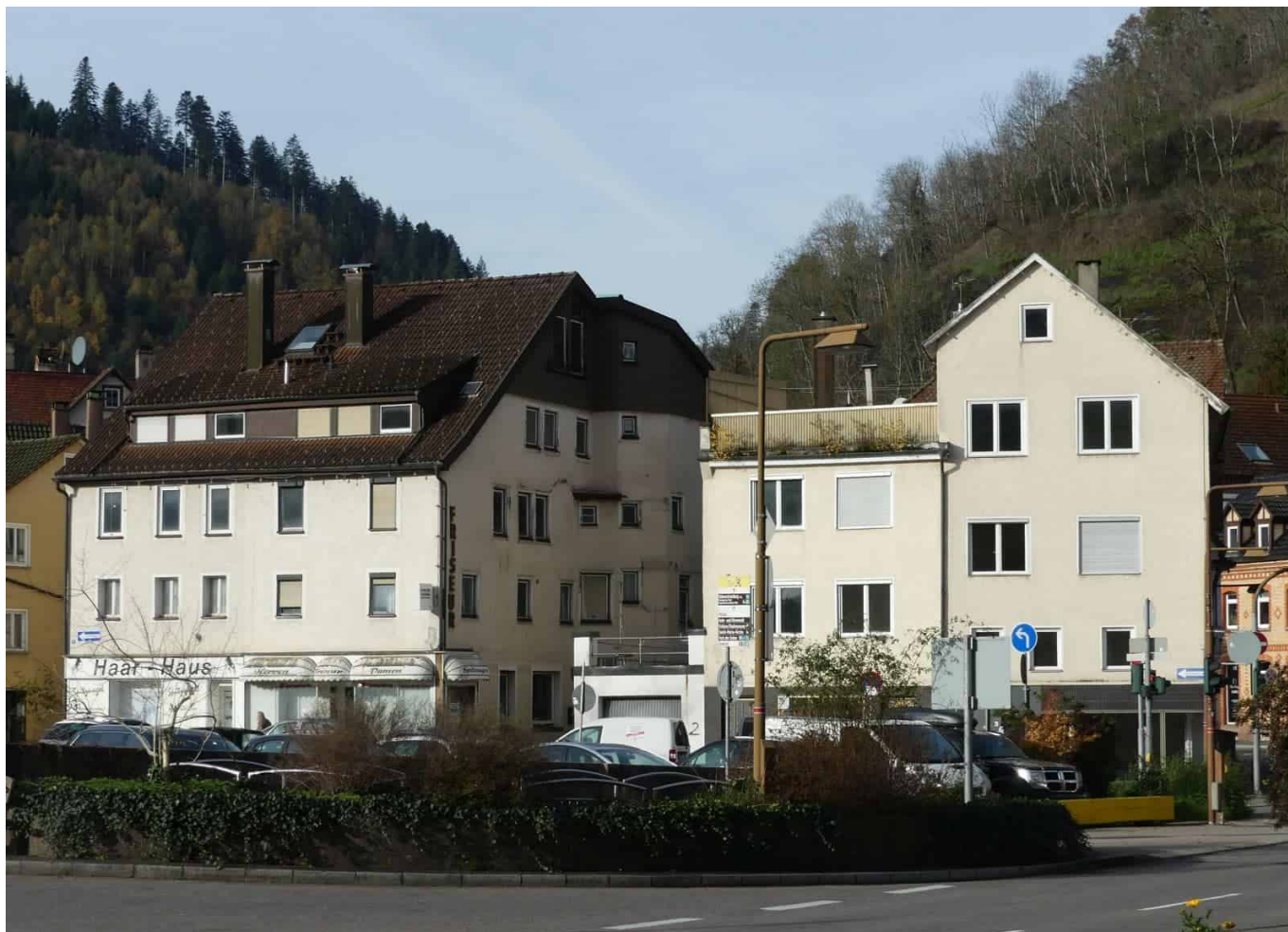
Die beiden ersten Häuser an der Lauterbacher Straße werden demnächst abgerissen. Foto: him
