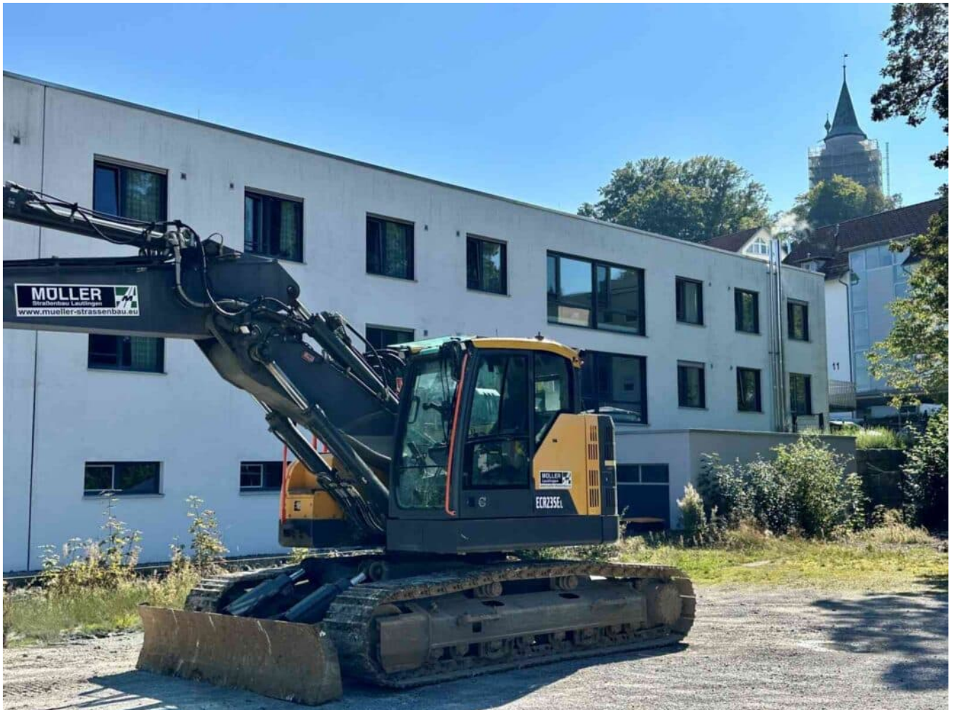
Baustelle beim neuen Spital. Foto: Stadt Rottweil / Hermann
