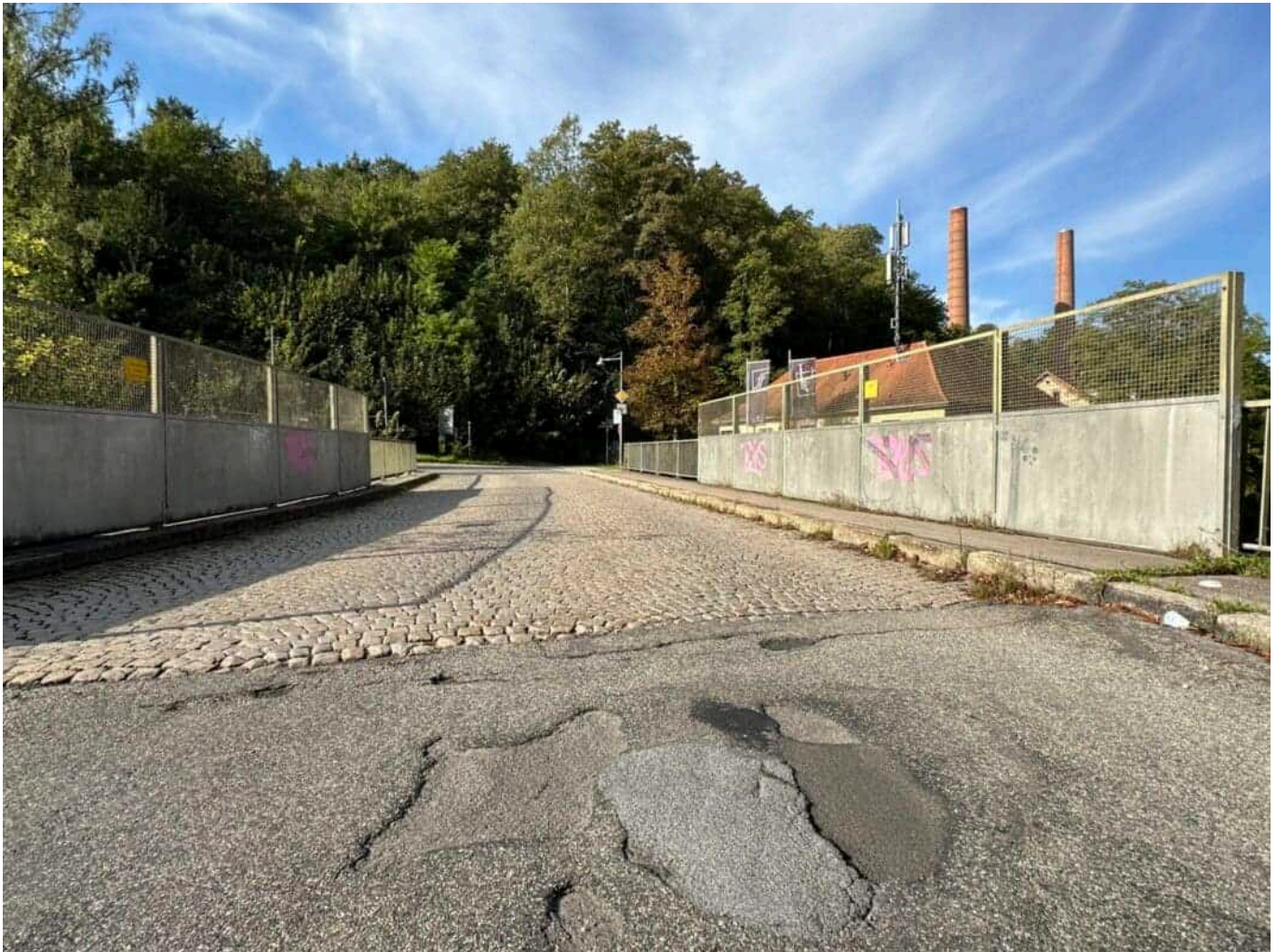
Marode Brücke im Neckartal. Foto: Stadt Rottweil / Hermann
