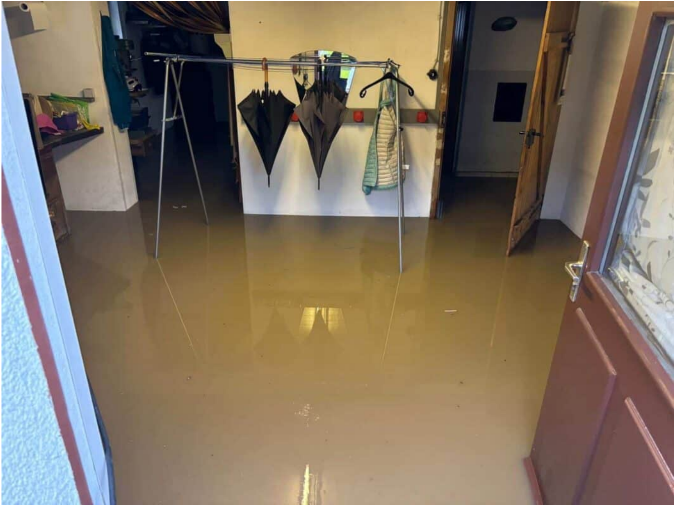
Blick in ein Gebäude in Neufra.
