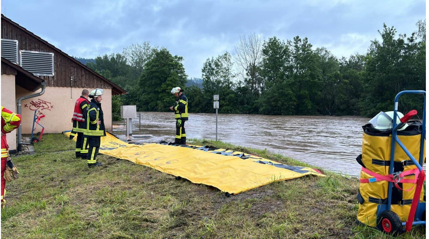
Mobiler Hochwasserschutz. Fotos: Blaulichtreport Rottweil
