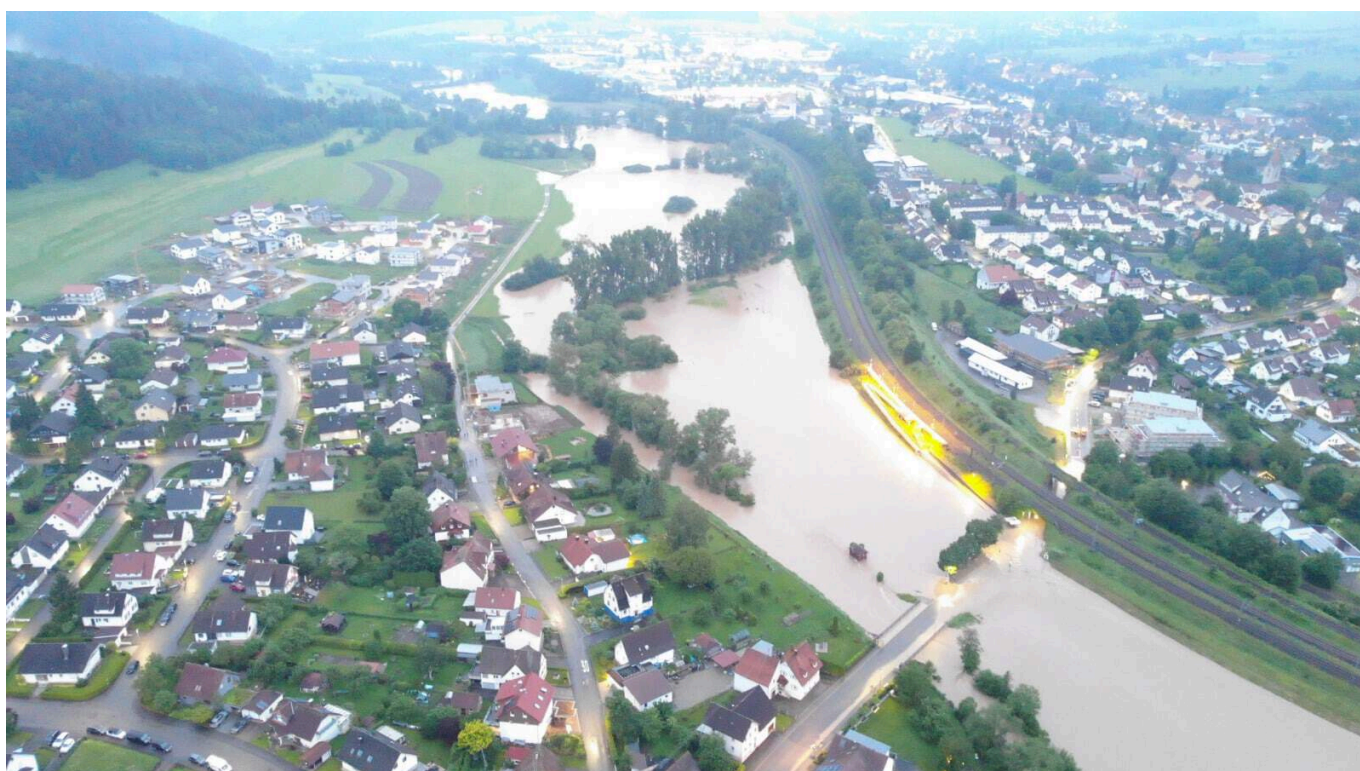
Überflutet und unpassierbar: der Durchgang zwischen Rottweil-Altstadt (rechts) und -Göllsdorf (links).
